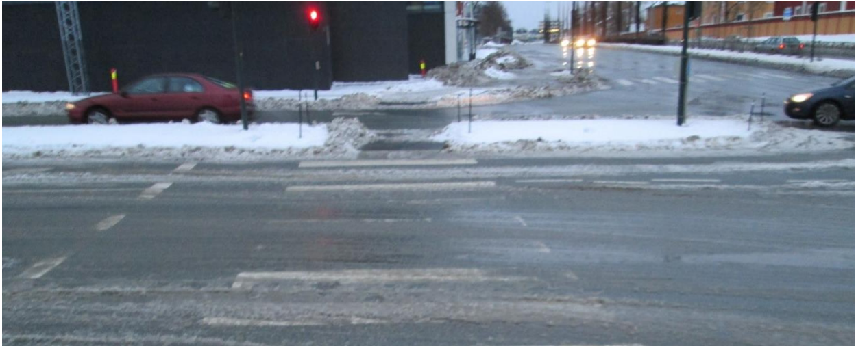
Bilde 15: Bredde, 2. februar. Bare halve øya i gangfeltet er brøytet i Strindvegen
