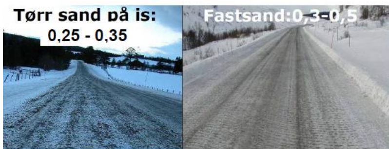
Figur 5-4 Friksjon på veg med isdekke strødd med sand og fastsand
