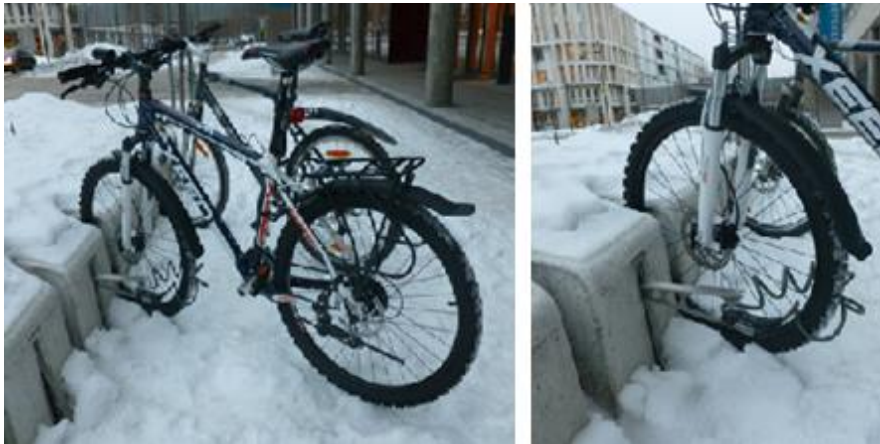
Figur 14. Integrert sykkelstativ med uttrekkbar metallklaff til sykkellås designet av Asplan Viak, Sør-Trøndelag
