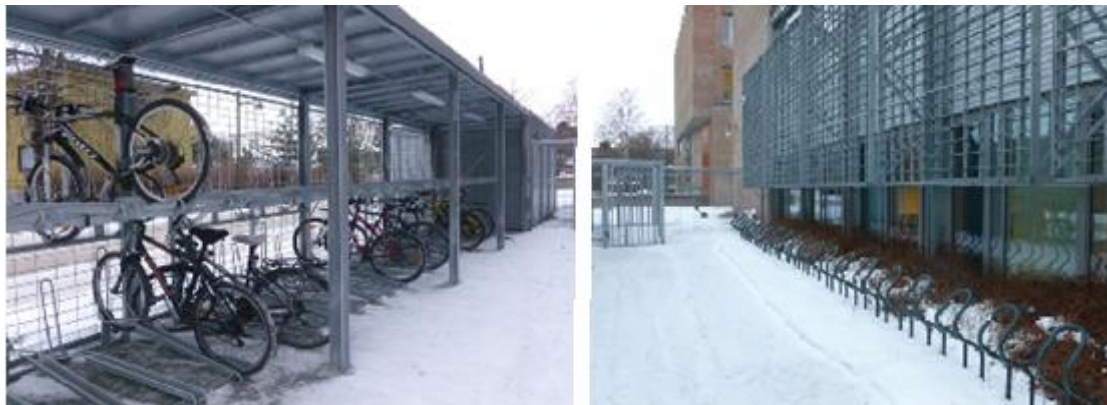
Figur 12. Avlåste, utendørs sykkelparkeringsanlegg ved St.Olavs Hospital
