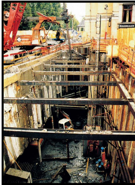
Figur 5-26: Bygging i åpen byggegrop på Nationaltheatret stasjon. (Jernbaneverket 1999)
