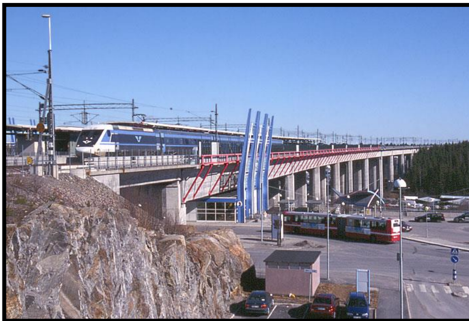
Figur 5-19: Södertälje stasjon er bygget på en bro, og er plassert like utenfor Stockholm. (Järnväg.net 2013)
