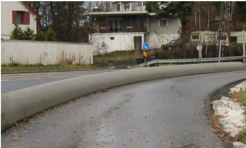
Figur 10 Plasstøpt betongrekkverk. Foto: Statens vegvesen, region sør.
