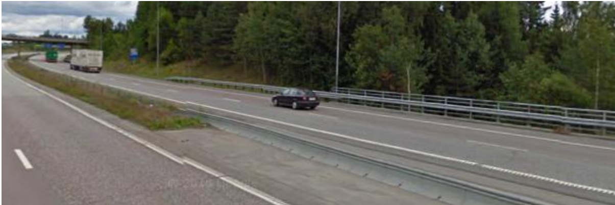
Figur 27 Bruk av miniguards i nødåpning på E6 i Akershus. Foto: maps.google.com .
