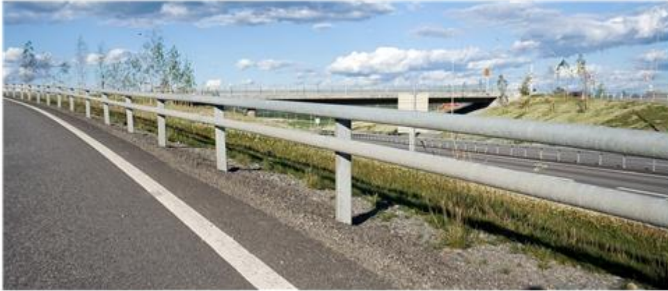
Figur 12 Rørrekkverk. Kilde: www.vikorsta.no
