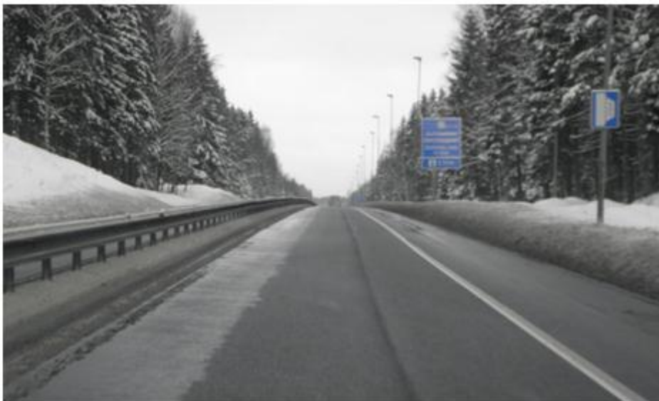
Figur 39 Avrenning fra isranke under midtrekkverk som har frosset. Kilde: ViaNova Plan og Trafikk AS, 2011.
