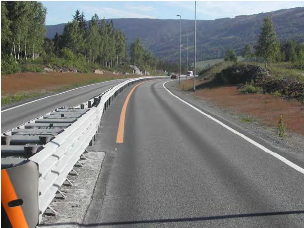
Figur 34 Støtpute på betongfundament som er høyere enn asfalt for øvrig. Kilde: Giæver m fl, 2006.
