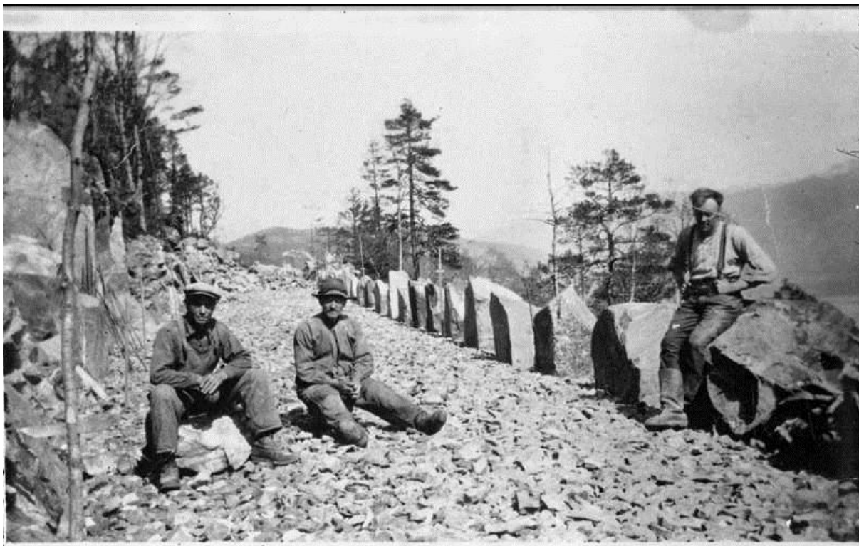
Figur 2 Vegarbeidere langs stabbesteiner på Vintraleå i Suldal fra ca 1926. Foto: Lars Gunnarson Aas, Ryfylkemuseet.
