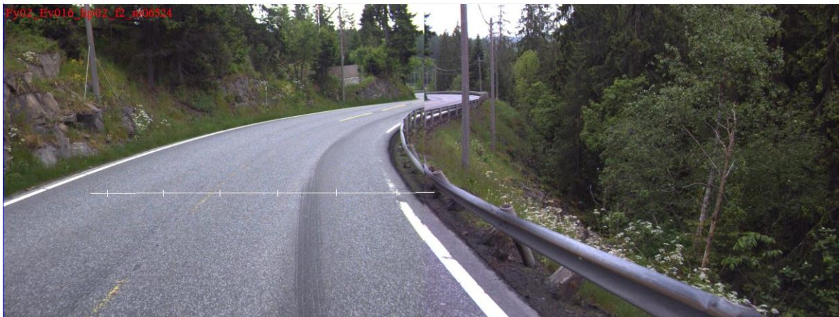
Figur 17 Hellende rekkverk på E16 i Akershus. Foto: ViaPPS.
