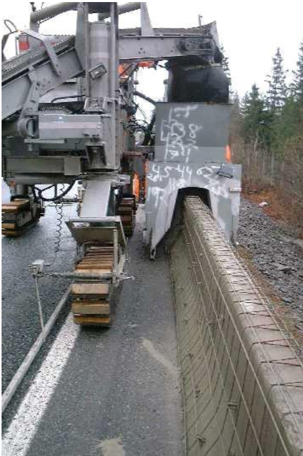
Figur 21 Støping av nytt betongrekkverk utenpå det gamle. Kilde: Statens vegvesen, 2006b.
