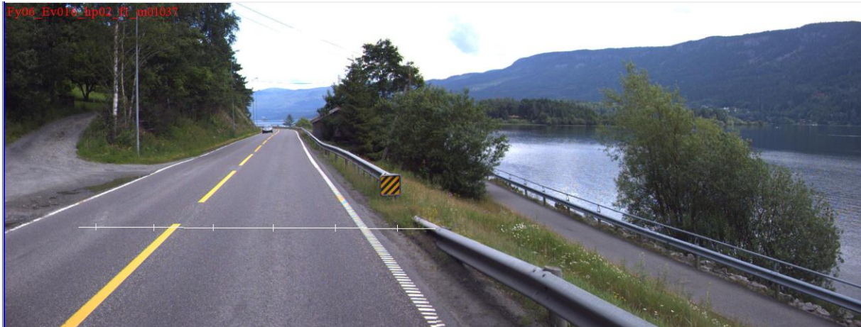
Figur 23 Gangåpning i rekkverket på E16 i Buskerud. Foto: ViaPPS.
