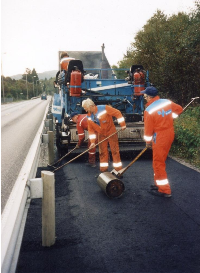
Figur 45 Asfaltlegging rundt rekkverksstolper. Foto: Erling Grønsdal.
