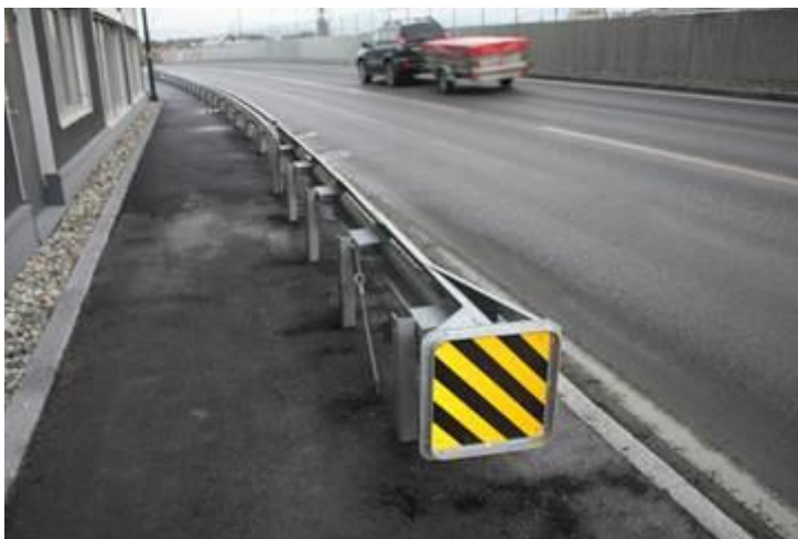
Figur 29 Rekkverk mellom smalt fortau og veg. Foto: Almar Aronsen, Statens vegvesen.
