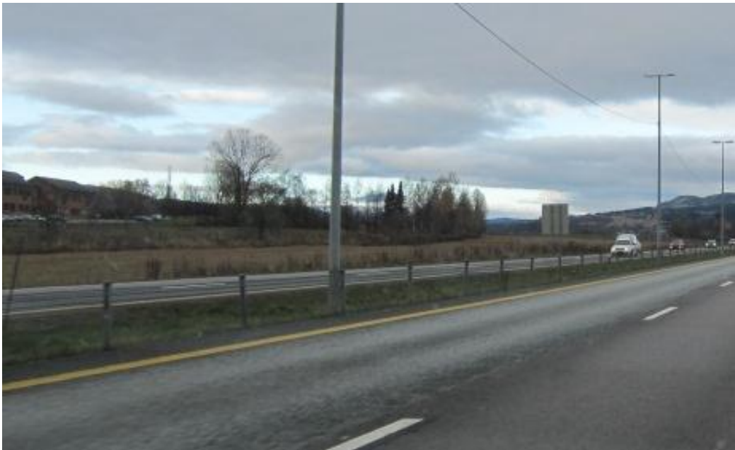
Figur 11 Wirerekkverk. Foto: Statens vegvesen, region sør.
