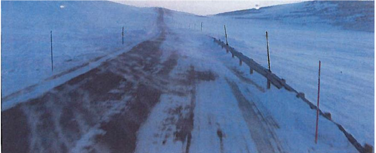
Figur 37 Fonndannelse ved stålskinnerekkverk. Kilde: Thøring, 2009.
