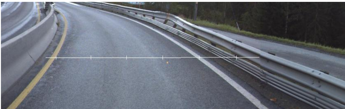
Figur 44 Rekkverk som skaper veggeffekt. Foto: ViaPPS.
