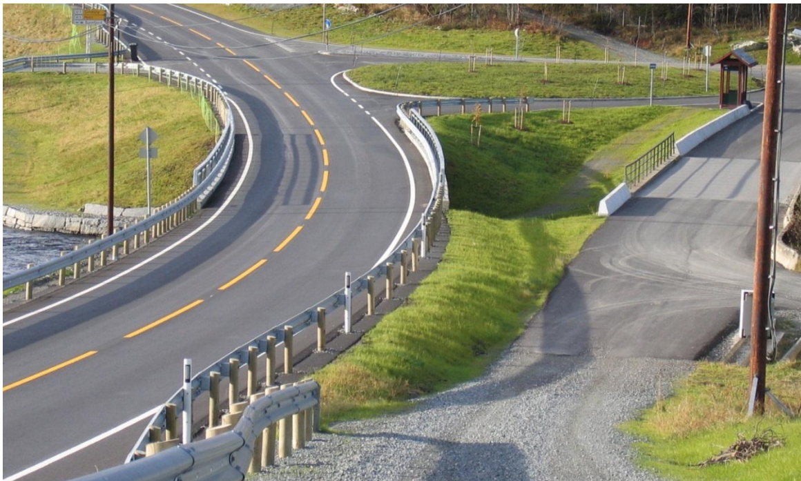
Figur 19 Bruk av flere rekkverkstyper innenfor et lite område. Foto: Lars Magnar Rønneid.
