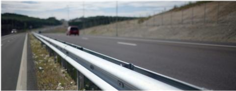
Figur 7 Dobbeltsidig stålskinnerekkerkverk. Kilde: www.vikorsta.no .
