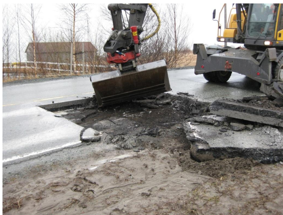
Figur 53 Bilde fra start oppgraving, asfalt fjernes.
