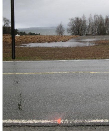
Figur 29 Dårlig drenering på jordet ved vegen slutten av mars ved måleplass 1.
