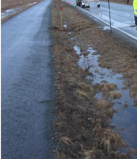
Figur 28 Dårlig drenering slutten av februar ved måleplass 1.
