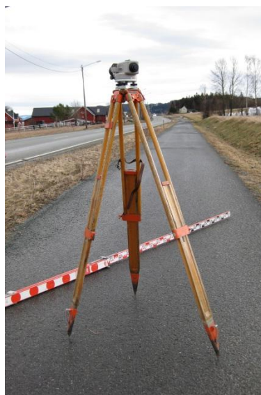
Figur 36 Nivellement ved Malvikvegen.
