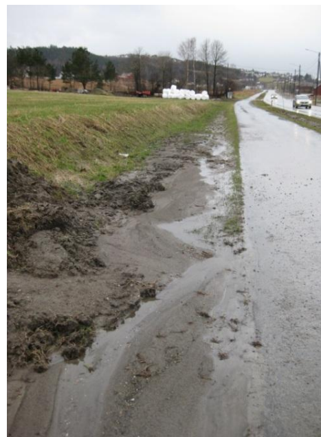
Figur 27 Dårlig drenering også senere i smelteperioden, mars 2012, ved måleclass 2.
