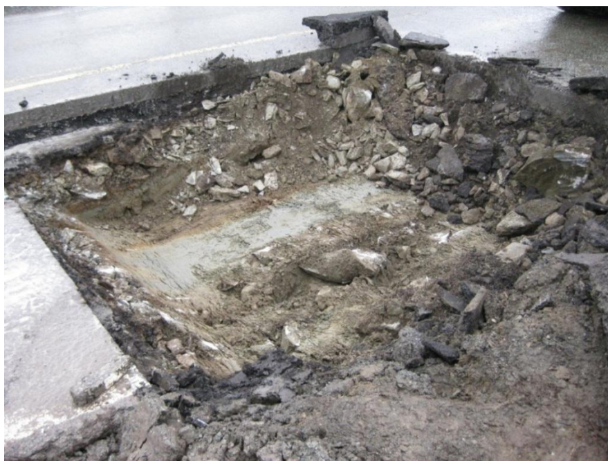
Figur 54 Lagvis fjerning av materiale.
