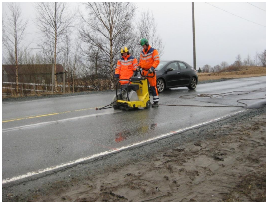
Figur 52 Asfalten sages opp for å kunne fjernes med gravemaskin.
