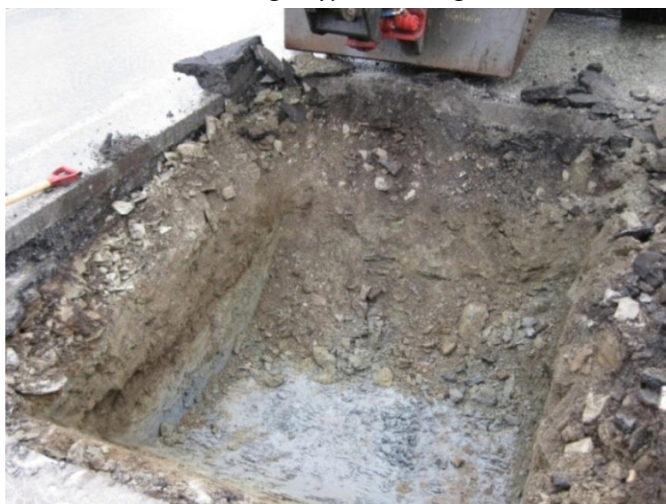
Figur 57 Bunnen av oppgravingsgrop.
