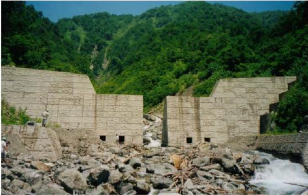
Figur 5.11: Spaltdam før flomskred og erosjon, foto: Mizuyama (2008)
