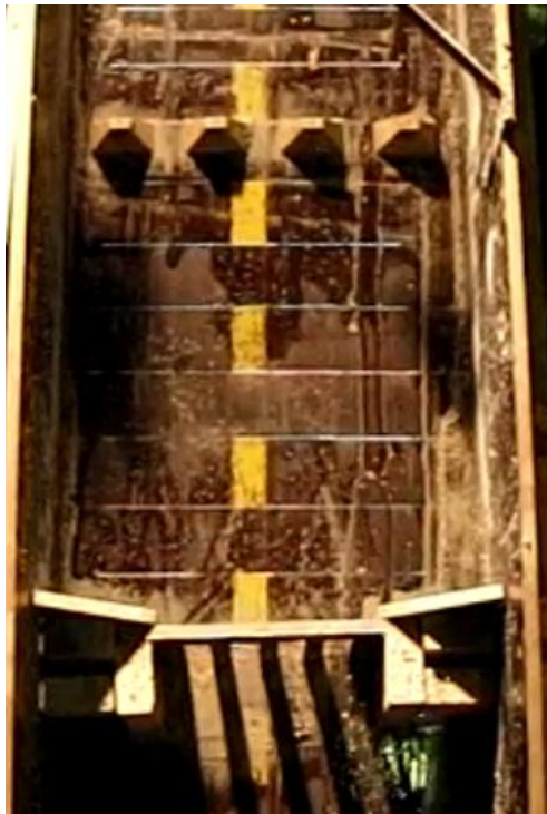
Figur 5.16: Oppsett av kombinasjonen 4 kjebler og 4 spalter kontrolldam. Foto: Fiskum (2012)
