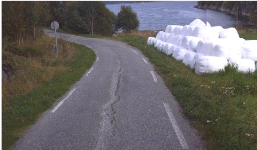
Bilde 18 Eksempel på sprekk midt i vegen. Strekningen med karakter H, Profil 1333. (NVDB, 2012)
