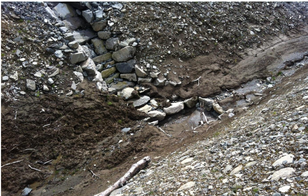
Figur 6-79 Blomasvora - inntak til stikkrenne i syd
