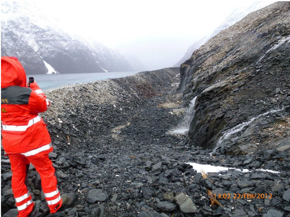
Figur 6-67 Seljesvora/Jonsoksvora sett fra sør
