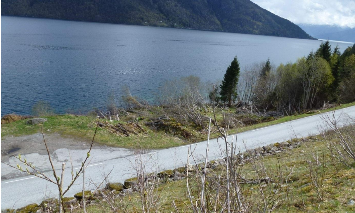
Figur 6-41 Sandskreda – Skader etter skred, vinteren 2012
