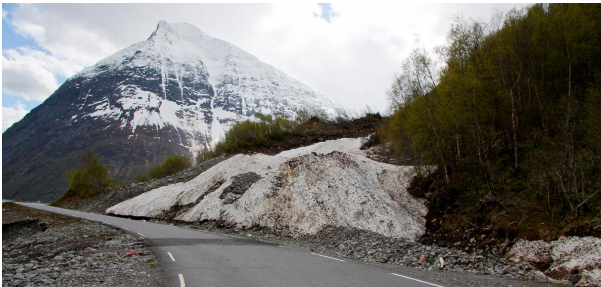
Figur 6-34 Seljesvora - skredsnø i tiltaket
