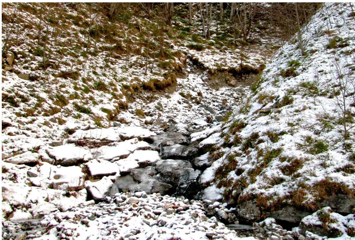
Figur 6-15 Storegjølet Sør – kanalisering av skredet inn til magasinet
