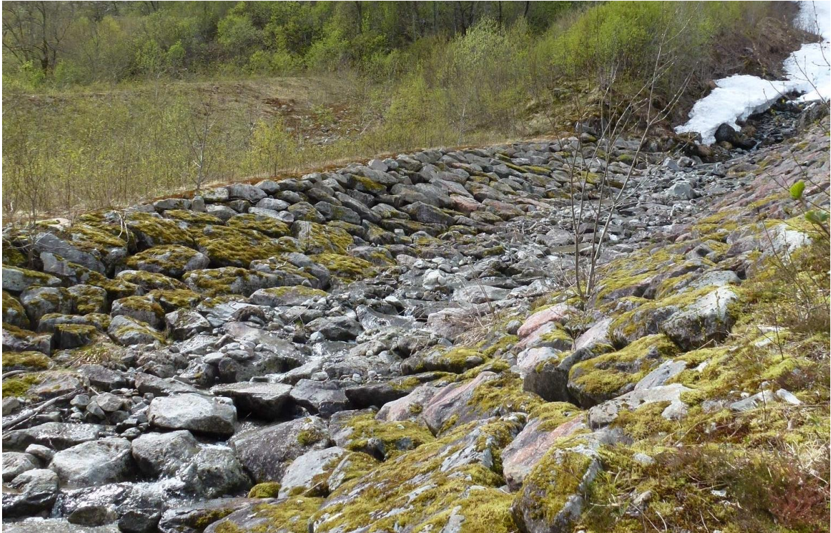
Figur 6-55 Breiskreda - steinplastret bekkeløp
