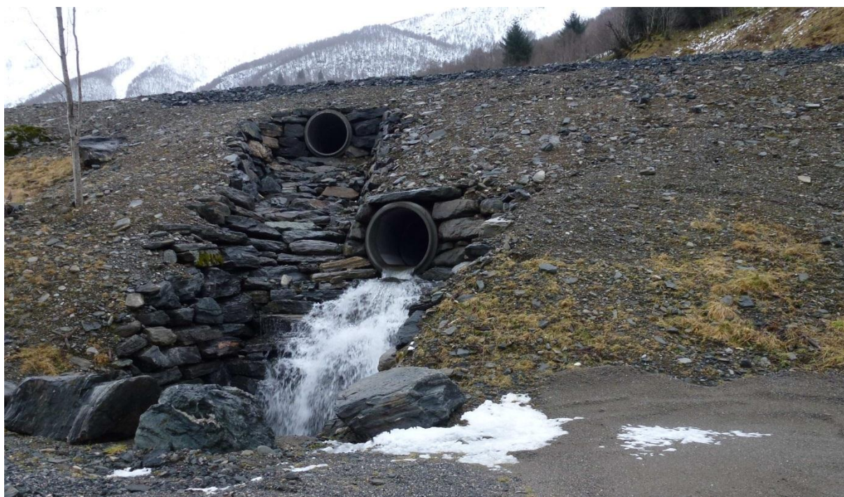
Figur 6-61 Storesvora – stikkrenner fra sørenden
