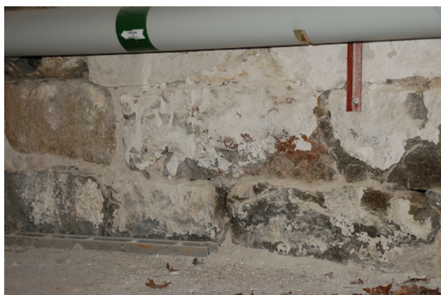
Figur 14 : Eksponert grunnmur av steinblokker, foto: Nils Færing
