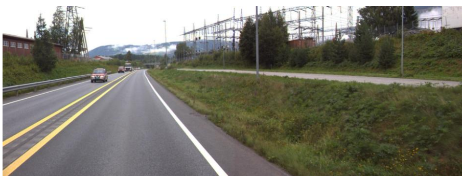
Figur 48 Nordlig kjøreretning på dagens E6. Trafostasjon til høyre, forsvarsanlegget til venstre.
