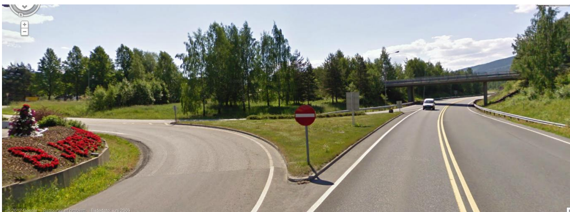
Figur 18 Sørlig kløverblad i Vingnes kryss, sett fra nord. Viser at det ikke er skille mellom på- og avkjøringsrampene. (Google maps, 2012)
