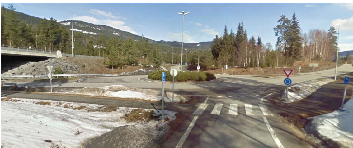
Figur 25 Kryssende gang- og sykkelveg. (Google maps, 2012)
