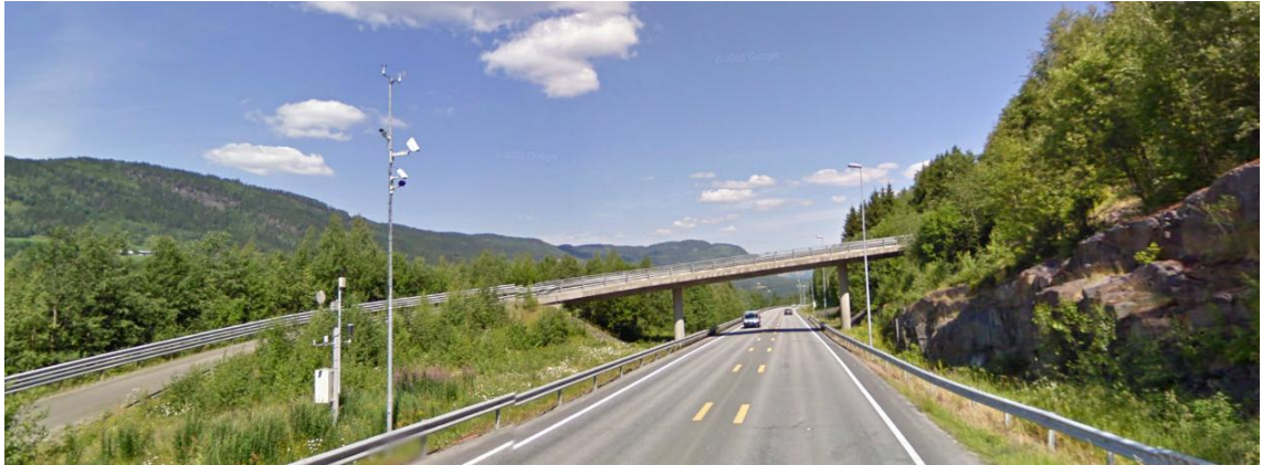
Figur 33 Eksempel på en kryssende bru som er uegnet for utvidelse. Her; Besserudvegen bru. (Google maps, 2012)
