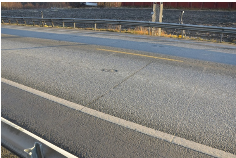
Figur 9 Magnetometer (STMS) installert i vegbanen. Foto Per Melen, Trafikverket
