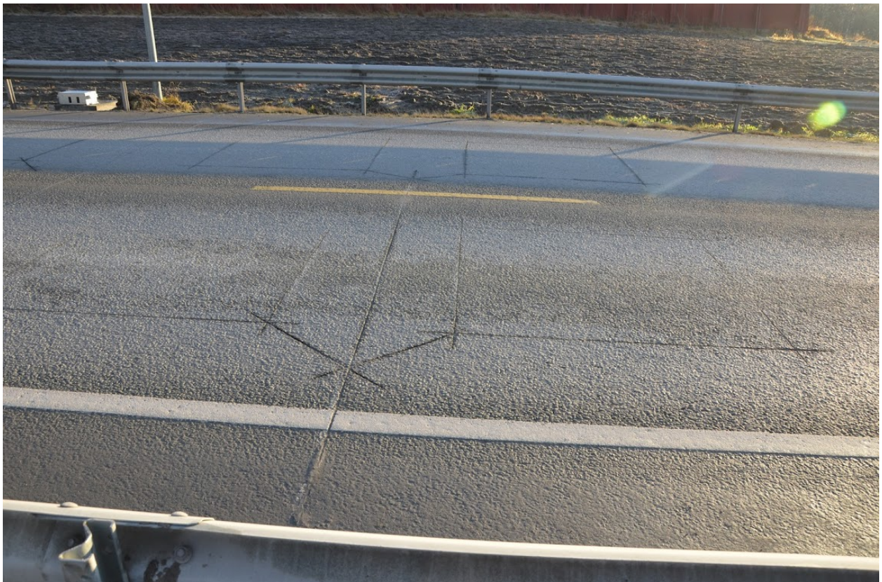
Figur 4 Norsk sløyfekonfigurasjon. Foto Per Melen, Trafikverket
