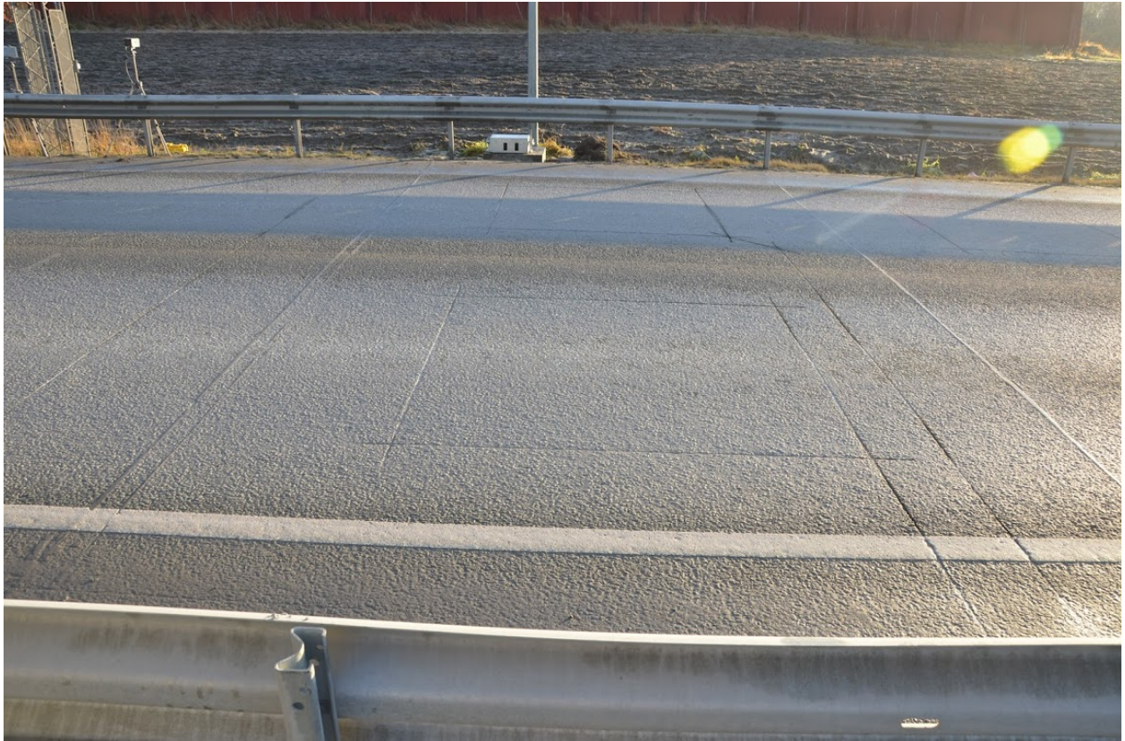
Figur 5 Norsk sløyfekonfigurasjon med piezoelektriske kabler. Foto Per Melen, Trafikverket
