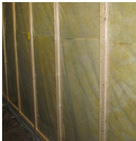
Figur 62 Forsøksveggen sett fra innvendig side etter isolasjon og dampsperre er montert.
