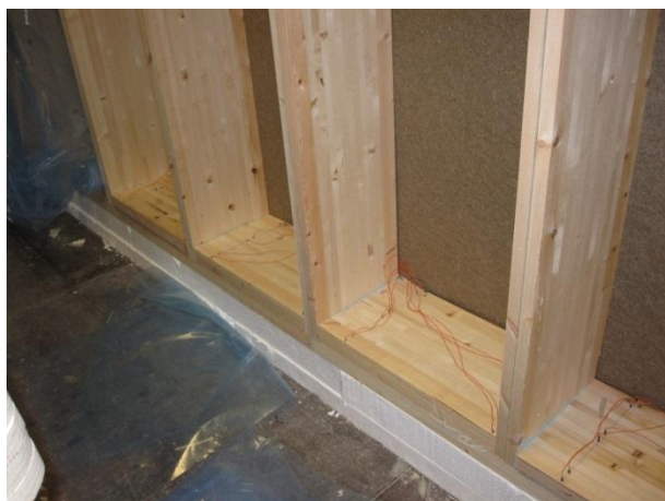
Figur 61 Montering av de oppfuktede bunnsvillene i forsøksveggen.
