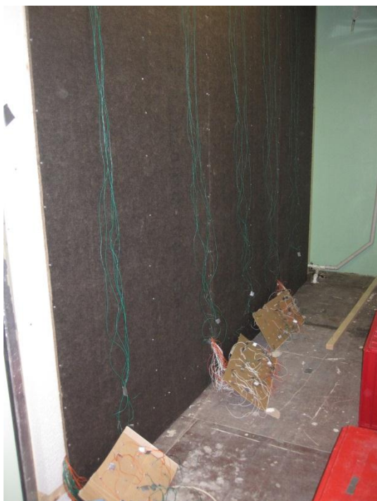
Figur 63 Forsøksveggen sett fra kald side. Ledningene ble ført ut på kald side for å sikre best mulig lufttetthet mot varm side.
