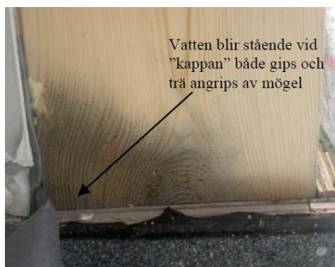
Figur 14 Eksempel på treverk som er angrepet av muggvekst grunnet kontakt med stående vann på gulvet. Kilde: (Land & Must, 2004).
