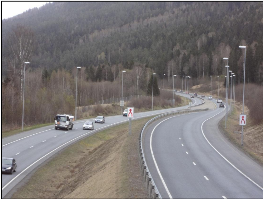
Figur 5. Terrassert løsning med 4 felt ved Ryghkollen. Bilde tatt mot øst
