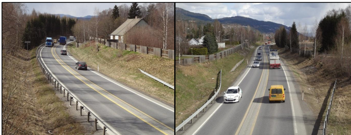
Figur 10. Bildet er tatt fra en overgangsbro på streknigen.
