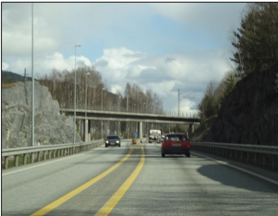
Figur 22. Jernbanebro ved Steinberg. Tatt mot øst.
