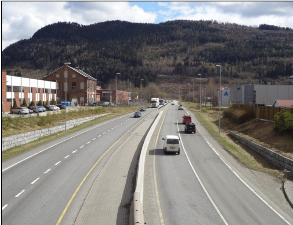
Figur 7. Bilde tatt mot sør fra det planskilte krysset i Mjøndalen
