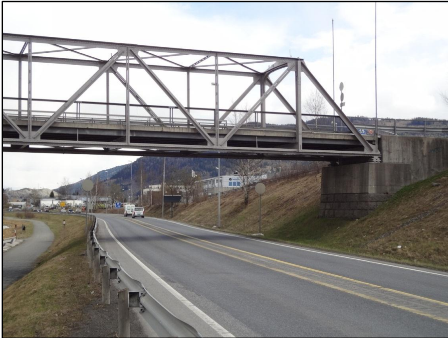
Figur 21. Mjøndalen bru. Bildet er tatt mot øst.
