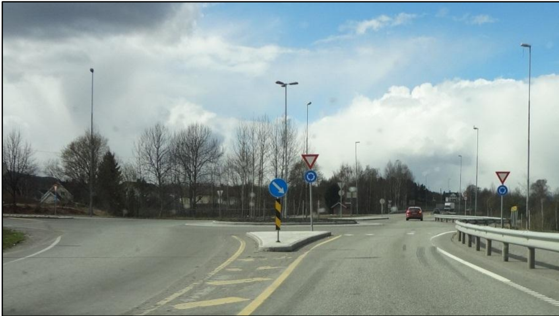
Figur 20. Den nye rundkjøringen i Mjøndalen.
