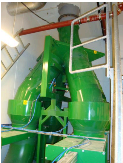
Figur 20 Avfallsug og kildesortering – fra avfallshåndteringssystemet ved St.Olavs Hospital i Trondheim. Suget benyttes til å sortere i fire fraksjoner (Restavfall, plast, papir og konfidensielt papir). Avfallsfraksjon velges av brukeren når søppelet legges i en luke i korridor, og sluses deretter ned i riktig rørsystem når det faller ned i krysset som er vist på bildet. Derfra suges søppelet videre til selve avfallssentralen (Foto: forfatteren, mars 2009)
