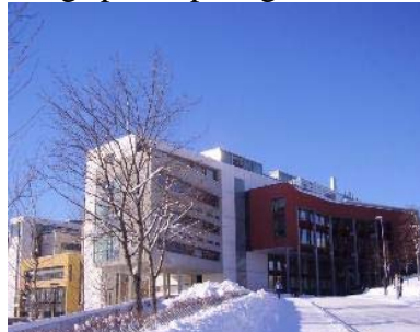
NTNU-Realfabygget(137 HVAC system)
