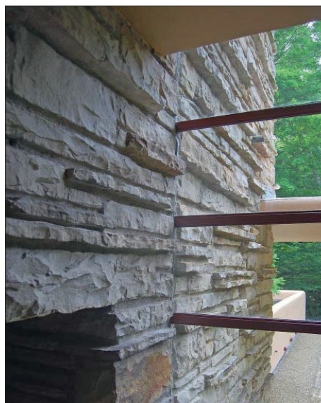
Fig. 7.2.25. Vindusløsning der glasset er ført inn i slisse i steinveggen og tetningen er murtørel. Vakker detalj, men teknisk problematisk. Kilde: Helge Solberg - Privat fotoarkiv.
