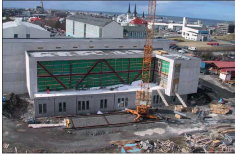
Fig 7.5.11. Betongarbeid i slutfasen. Foto: Bragi Thor Josefson - Privat fotoarkiv.
