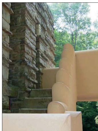
Fig. 7.2.3. Grovt oppmurte vegger og glattpusset betong med avrundede kanter malt i lys farge. Foto: Bolender, Ronald (2004).
