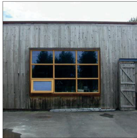
Fig. 7.4.26. Fasade mot vest som viser panelkledningen og det store utenpåliggende vinduet. Fotoet er fra juli 2002. Det bemerkes at fasaden på dette tidspunktet hadde blitt utbedret på grunn av de omtalte fuktforårsakede byggskadene.
