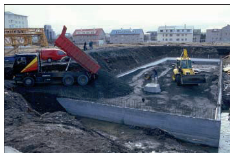
Fig 7.5.10. Arbeid med fundamenter. Foto: Bragi Thor Josefson - Privat fotoarkiv.
