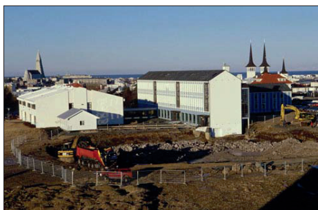
Fig 7.5.9. Graving av byggegropa i februar 2001. Foto: Bragi Thor Josefson - Privat fotoarkiv.
