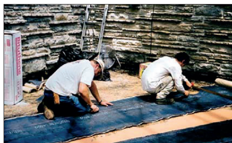
Fig. 7.2.36. Taktekkingsarbeid på takterrasser. Kilde: Gawlik & Robinson (2003).
