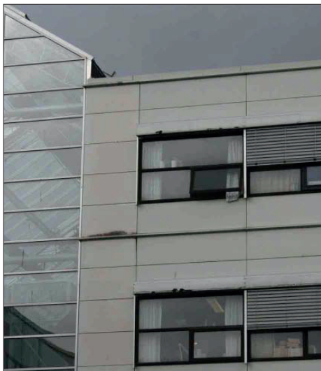
Fig 7.3.6. Fasade mot sør. Fasaden er kledd med hvite eternittplater.
