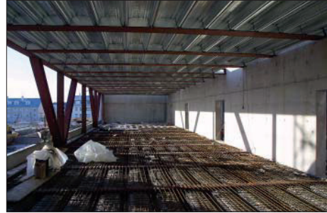
Fig 7.5.12. Innvendig oppbygging av betongdekket vises. Foto: Bragi Thor Josefson - Privat fotoarkiv.
