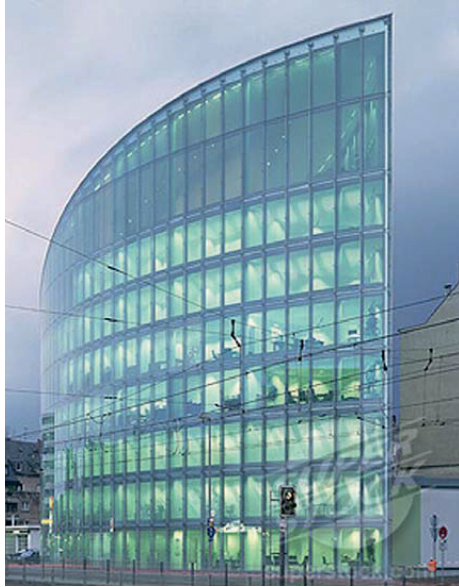
Fig 3.33. The Business Promotion Centre in Duisburg (1988-1993). Bygget har øyeformet grunnplan, konkav takform og fasader av speilende glass. Kilde: Foster+Partners (1988-1993).
