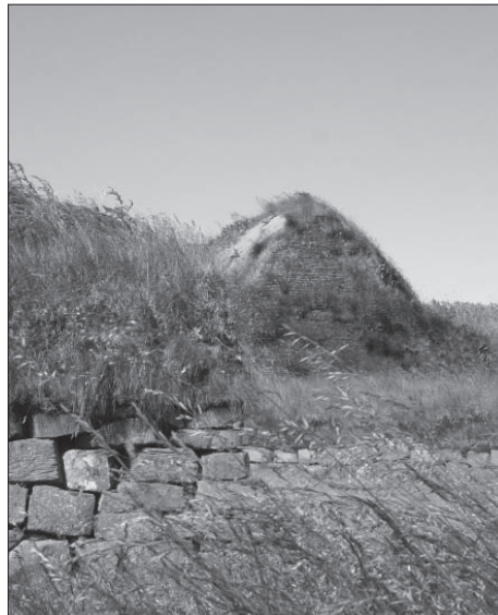
Fig 3.5. Eksempler på solid konstruksjon. Et hus av stein og torv i Thorsardal i Island. En rekonstruksjon av et langhus fra vikingtiden.
