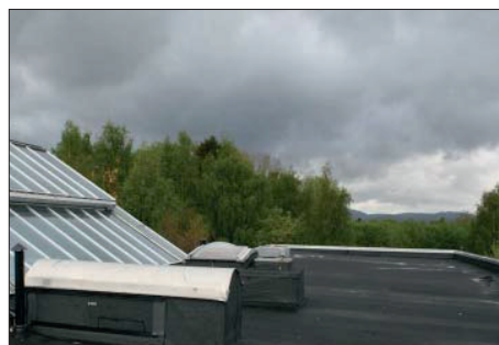
Fig. 7.3.32. Nytt tak Bygg 1, juni 2010.
