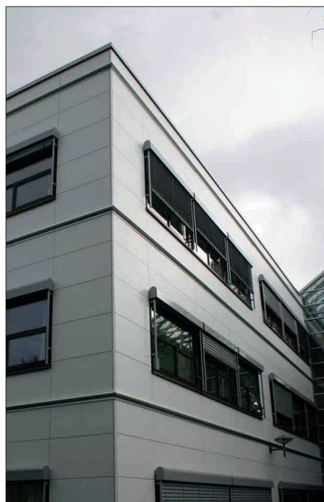
Fig. 7.3.33. Ny fasade, Bygg 1, juni 2010.
