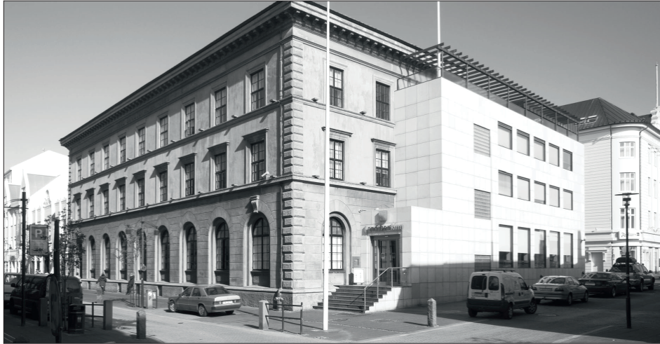
Fig 3.2. Landsbanken i Reykjavik. Eksempel på to byggestiler i samme byggverk. Et bankbygg fra 1924 i neoklassisk stil og et tilbygg fra 1934 i funksjonalistisk stil.
