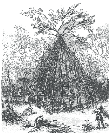
Fig 3.4. Eksempler på flettverkskonstruksjon. Tegningen skal illustrere den første hytten slik Violet-le Duc forestilte seg den. Kilde: Viollet-le-Duc & Hearn (1990), side 26.
