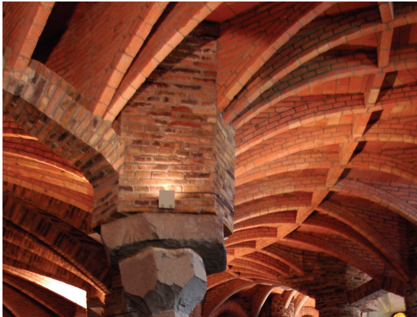
Teglstein er små, "molekylære" byggeklosser som er fleksible i forhold til varierende konstruksjonsmessige behov og arkitektoniske uttrykk. Hvelv i krypten under Colonia Güell, Catalonia. Ark: A. Gaudi 1898 (Foto:Jan Siem)
