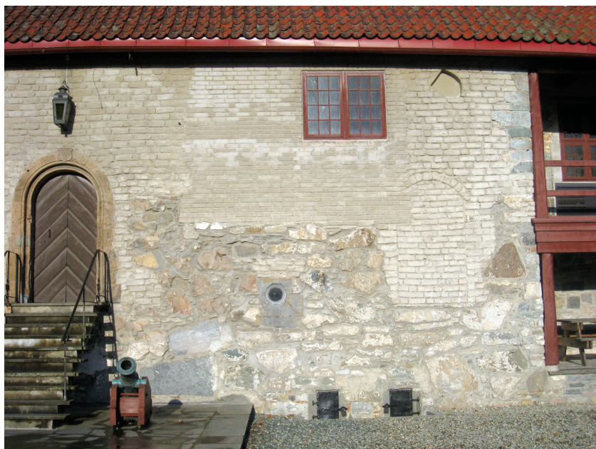
Yttervegg av naturstein og tegl som gjenspeiler bruksmessige endringer. Erkebispegården i Trondheim; vestfløy oppført 1300-1753, senest restaurert i 2005. (Foto: A. S. Nordby)
