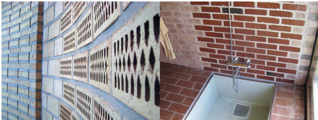
Tegl brukt som akustisk regulerende element i trap- perom. Realfagbygget, Gløshaugen av Narud Stokke Wiig/ Hus Arkitekter 2001 (Foto: A. S. Nordby)
