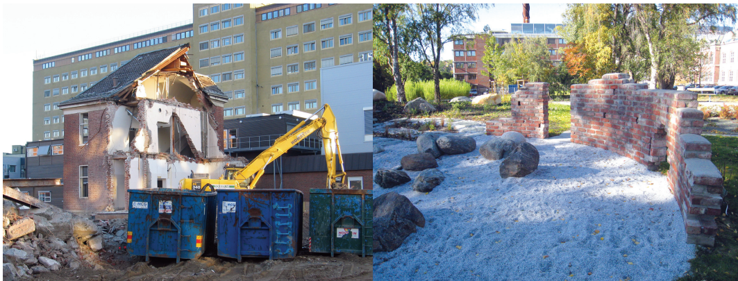
St. Olavs universitets-sykehus 2005: Hudavdelingen fra 1800-tallet rives for å gi plass til nye sykehusbygninger, og prosjektet oppnår høy grad av lokal materialgjenvinning gjennom knusing av masser. (Foto: R. Bohne)
