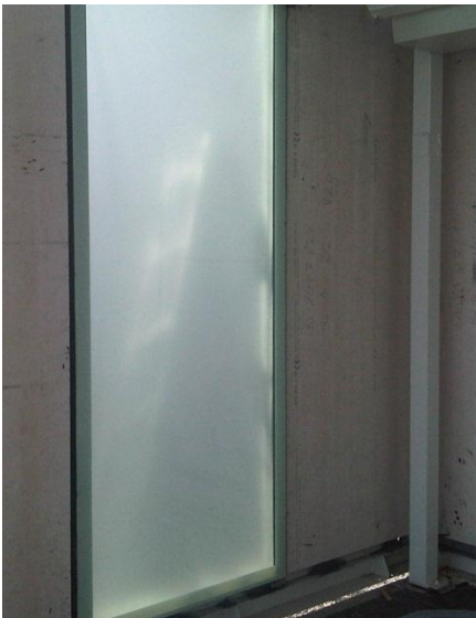
Figur 16 Eksempler på prøver av Qbiss Air med translusent glass.
