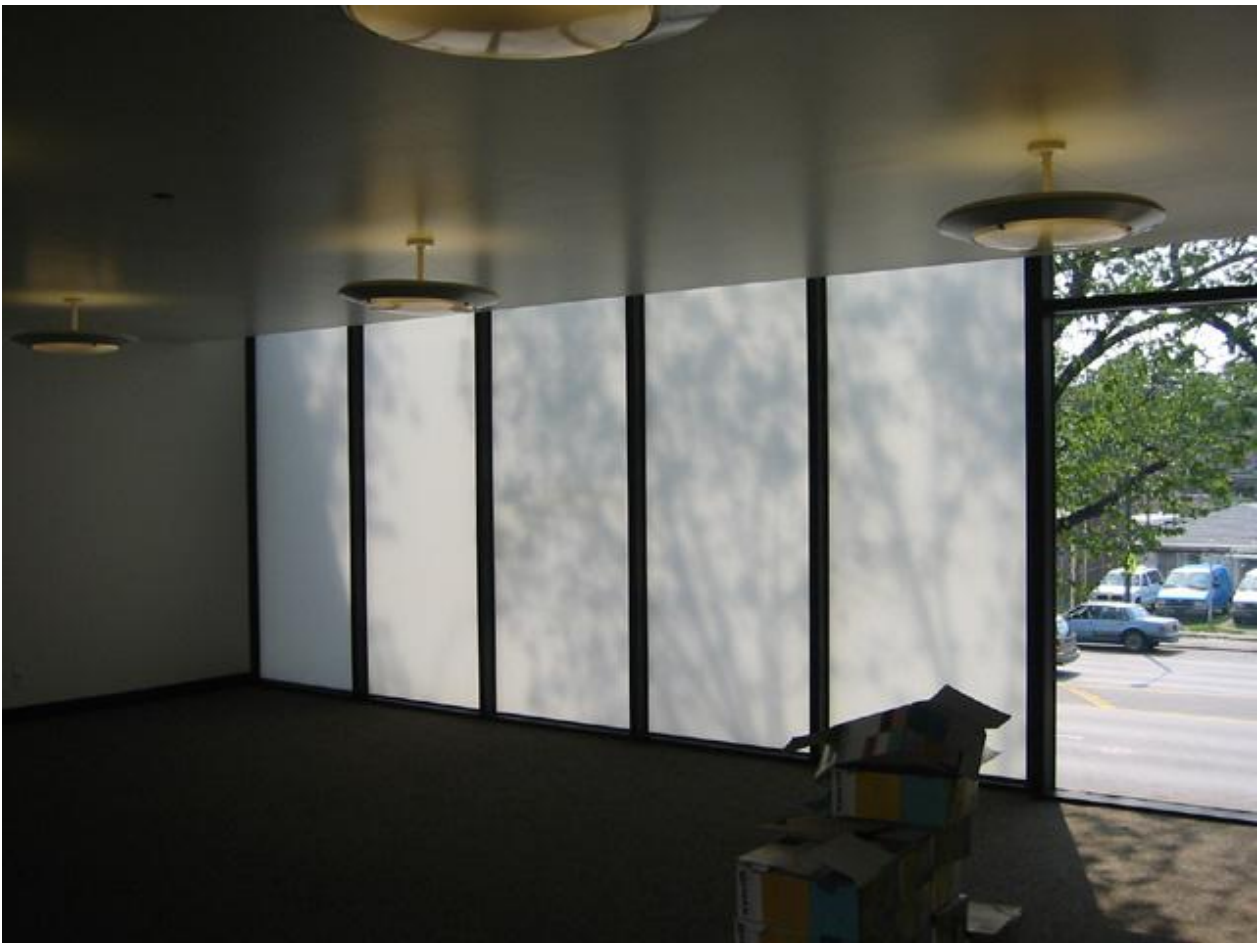
Figur 12 Solera brukt som både dagslyskilde og visuell avskjerming mot gaten. Trærnes skygger fanges opp i den lysende flaten.
