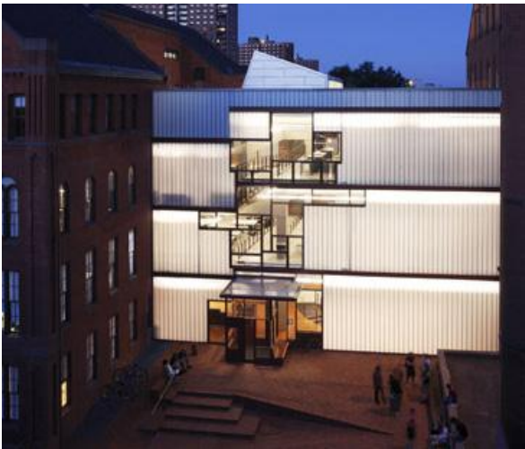
Figur 2 Pratt Institute, Higgins Hall Insertion, arkitekt Steven Holl. Eksempel på bruk av translusent glassplank.
