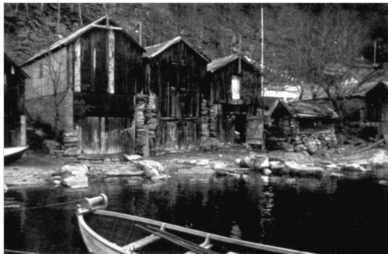
Figur 8.5.4 Bevaringsverdig naustmiljø i Gei- ranger.
