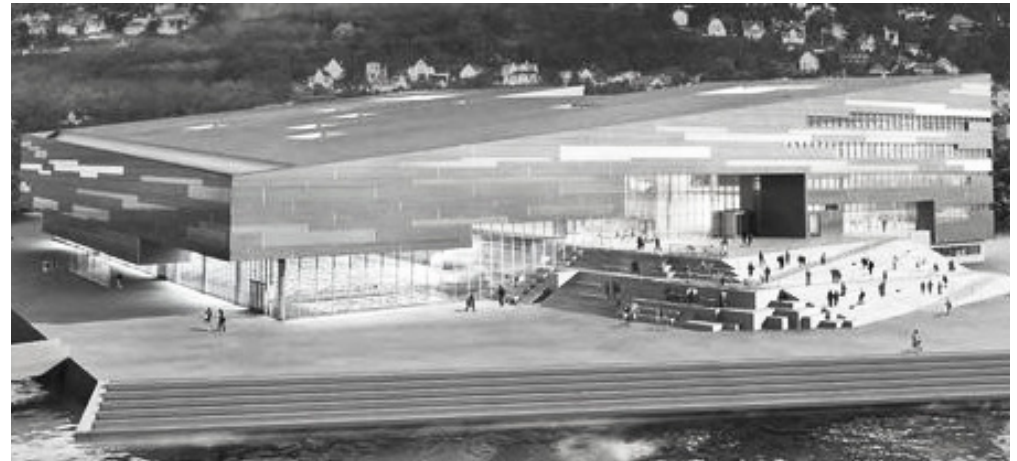
5 Dette er et bygg som er delt i to; Helleren som er en ny svømmehall / -stadion, og Amalie Skram Skole som er en videregående skole (som skal ta over for byskolene Tangs, Bjørgvin og Bergen Handelsgymnasium). Bygget skal etter planen stå ferdig i 2014. Det er de danske arkitektene KHR (Krohn Hartvig Rasmussen) som har tegnet bygget, etter at de vant arkitektkonkurransen som ble holdt.
