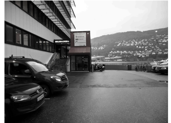
3 Inngang til bygg som ligger inntil Store Lungegårdsvann, rett ved Netpuns tomt
