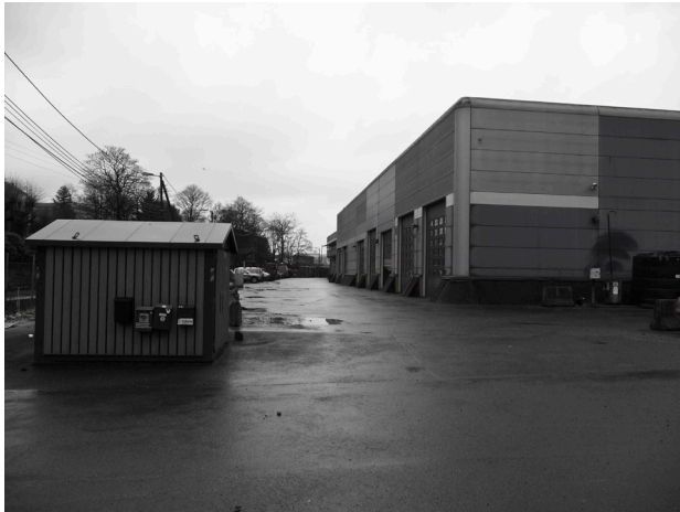
1 Dette lager/industribygget skal på sikt (innen 2019) rives, og området skal brukes til bolig- og sentrumsformål.
