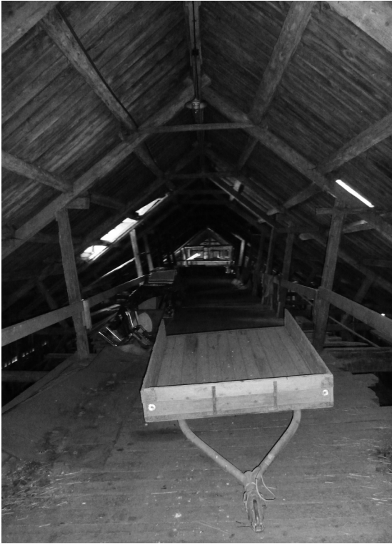
10. Låvebrua i tredje etasje i den gamle driftsbygningen.
