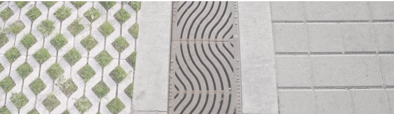
Tenkt materialovergang ved overgang til townhouse og bygårder fra indre shared space gate. Permeable overflater langs husveggene og avrenning tar seg av overvannshåndteringen i gaten.
