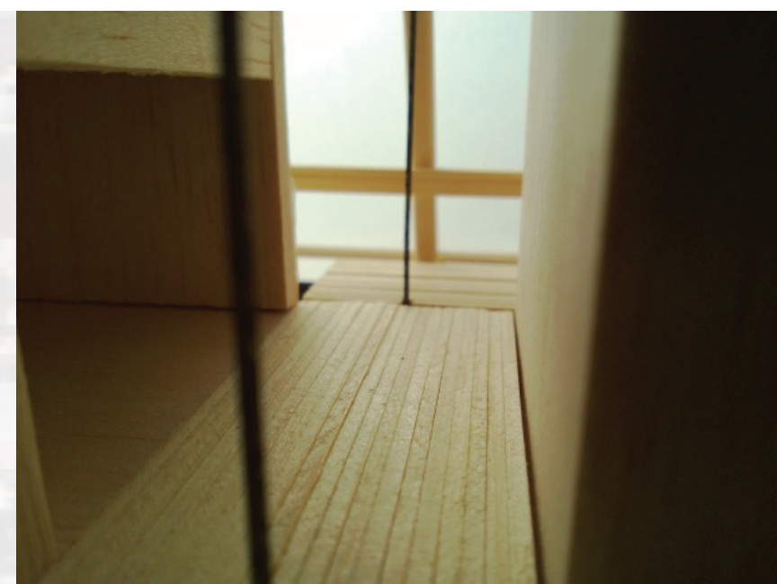
Polykarbonatplatene diffuserer dagslyset inn i gangsonen mellom boksene. Synlig konstruksjon.
