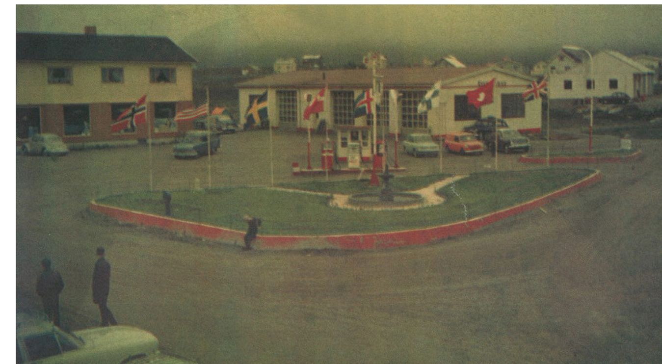
Esso-tomta 1965. Dette er sentrum i sentrum, ingen tvi om det. Internasjonal flogrekk, skulptur med fontene og hvit grus, betongkant det går an å hvile seg mot. Her reiste de julegrana og markerte spesielle anledninger.
