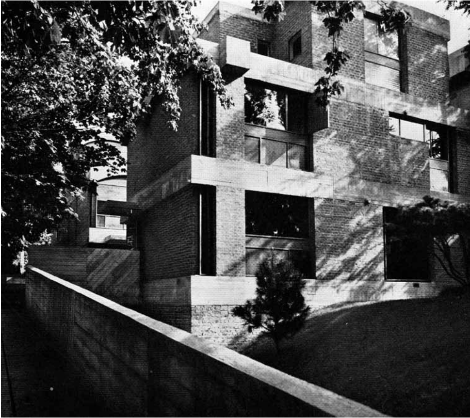
Fig. 17. Le Corbusier; Maisons Jaoul, Neuilly utenfor Paris (1956) Ifølge Reyner Banham bidro dette prosjektet til å definere det man senere skulle komme til å forstå som "the brutalist style". De to husene er murt med grove teglstein av algeriske håndverkere, og etasjeskillere i "béton brut" er eksponert i fasadene. Fasade sett fra adkomstrampen.
