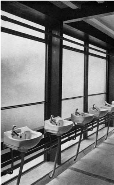
Fig. 14-15. Alison og Peter Smithson, Hunstanton secondary school. Interiør. Til venstre: vaskene er montert rett på stålkonstruksjonen, og avløpene inngår som del av det visuelle miljøet. Til høyre: Klasserom i 2. etasje som tydelig viser hva Alison Smithson mente med "the ware-house aesthetic".
