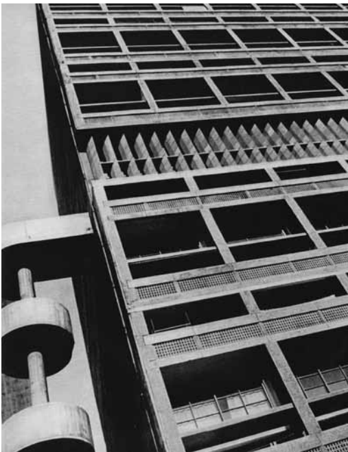
Fig. 4-5. Le Corbusier; Unite d' Habitation, Marseille (1949) "With the completion of the Unité life has return" kommenterte Peter og Alison Smithson i 1954. Bildet til høyre viser Corbusiers bruk av "béton brut", der betongen forblir upusset og forskalingsmerkene er synlige.
