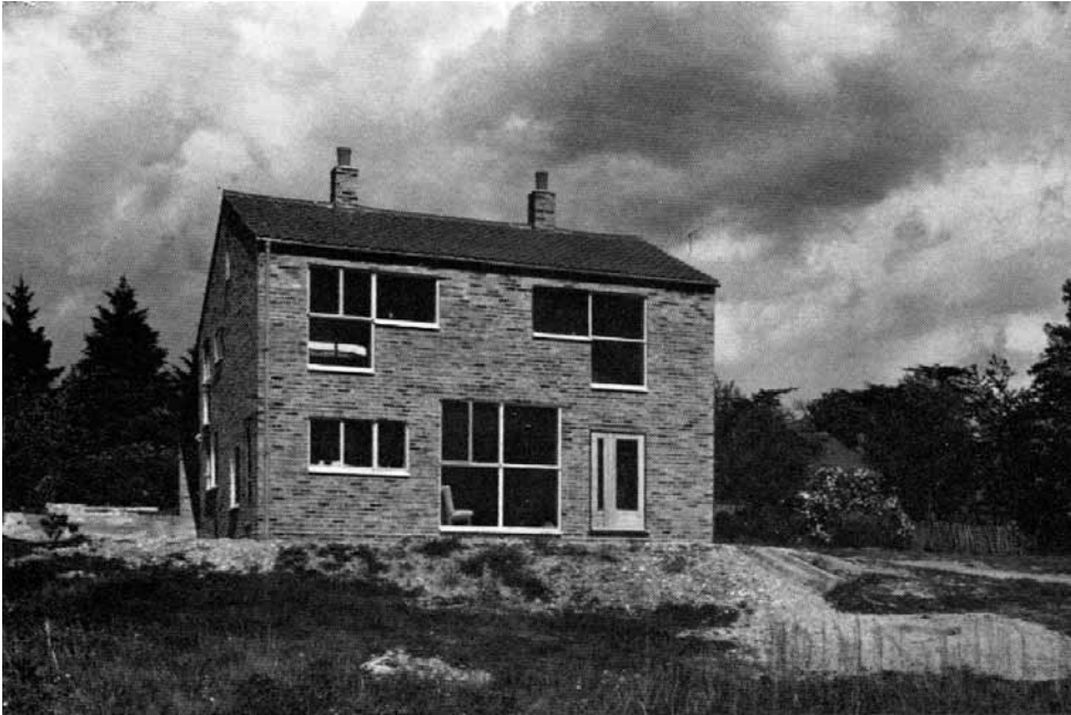
Fig. 60. Alison og Peter Smithson; Sugden House, Watford (1956). Fasaden viser hvordan vinduene er plassert assymetrisk og helt etter tektoniske og funksjonelle hensyn. Paret forklarte vindusplasseringene slik: "the distribution of the windows ... deliberately allows the brickwork to flow together and ultimately coalesce with the roof".
