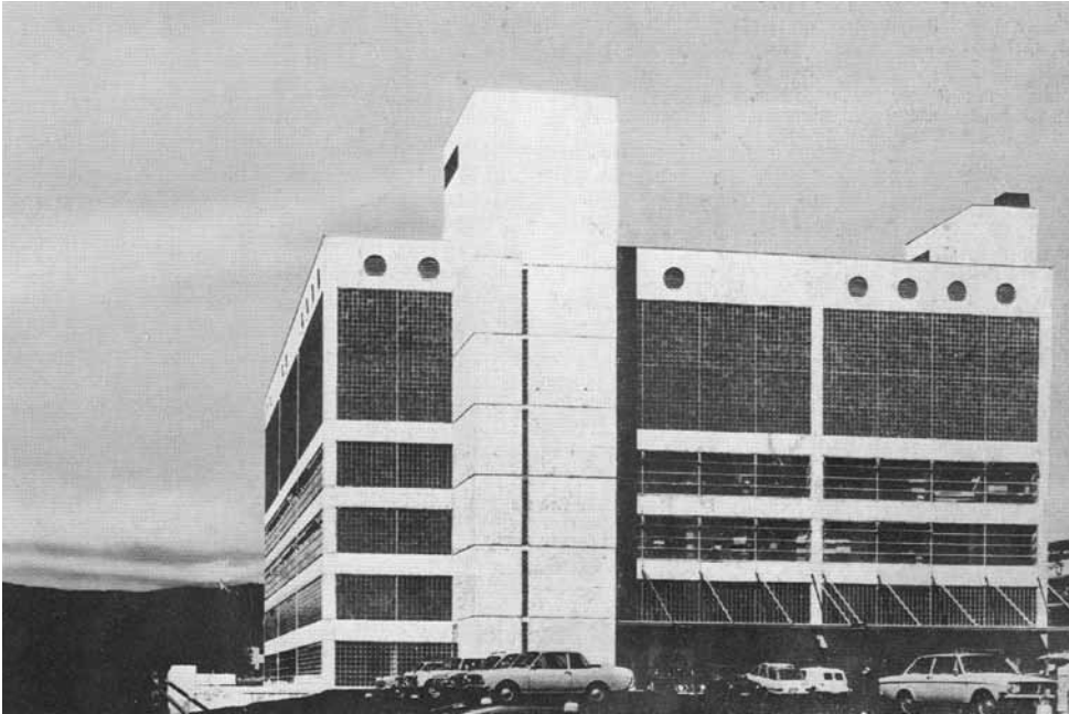
Fig. 35. Kjell Lund og Nils Slaatto; Chateau Neuf, Oslo (1971) Bygningens hovedform slekter på St.Hallvard, og består av en kube som omslutter et sirkulært hovedrom. Fasadene består av ubehandlet betong og terracottafliser. Prosjektet ble publisert i Byggekunst nr. 6/1971
