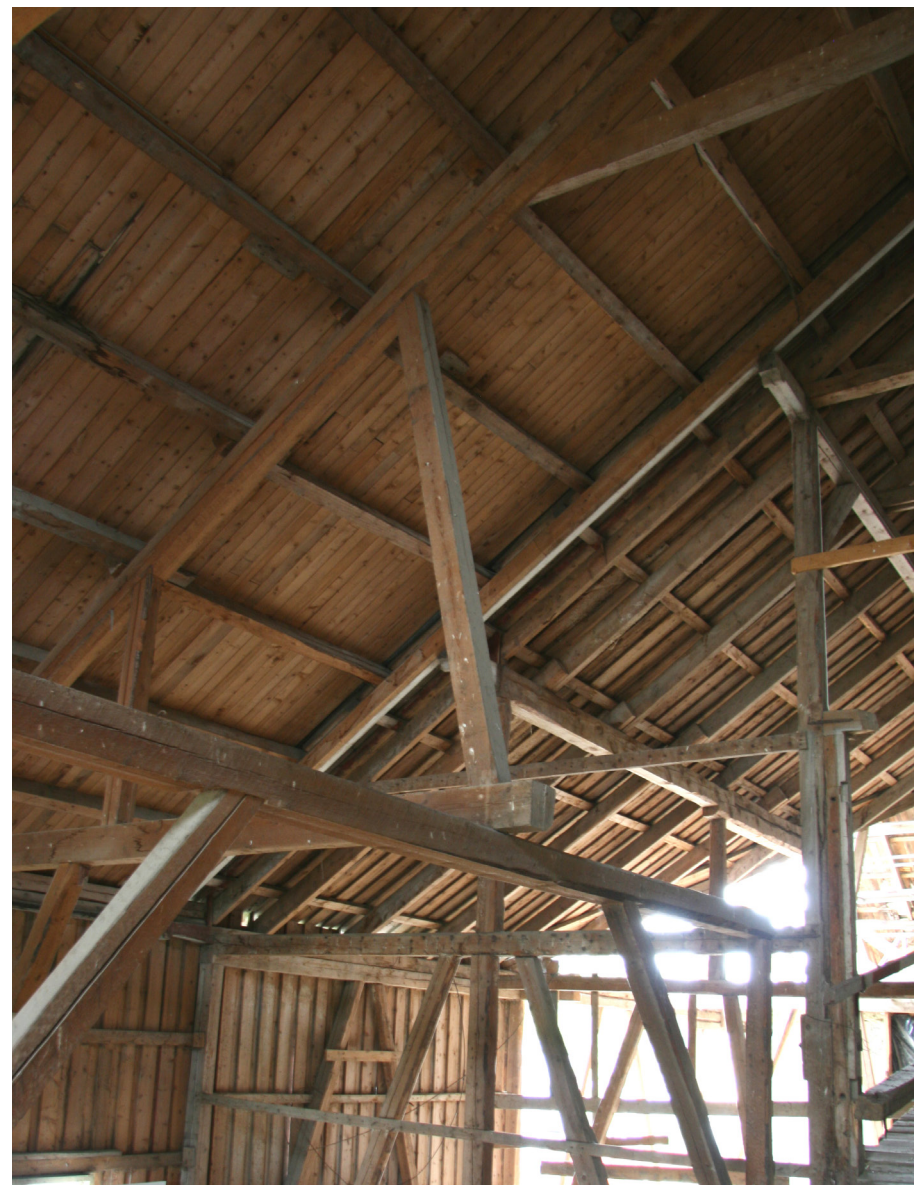
Møtet mellom gammel konstruksjon (i bakkant) og ny konstruksjon (i forkant)
