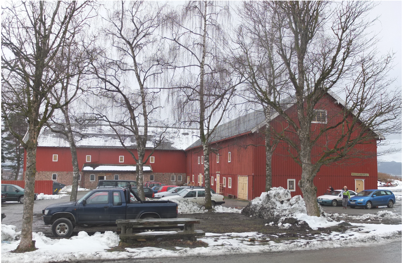
Gammelfjøset på Skjetlein sett fra nord. Nordfløyen til høyre, østfløyen til venstre.
