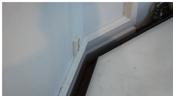
Villa Grande - tekniske føringer under nytt gulvsjikt.
