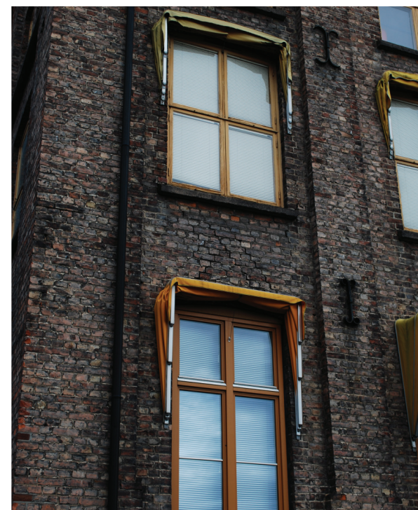
Akerselva - Nytt vindu nede utformet for å passe det gamle (over)
