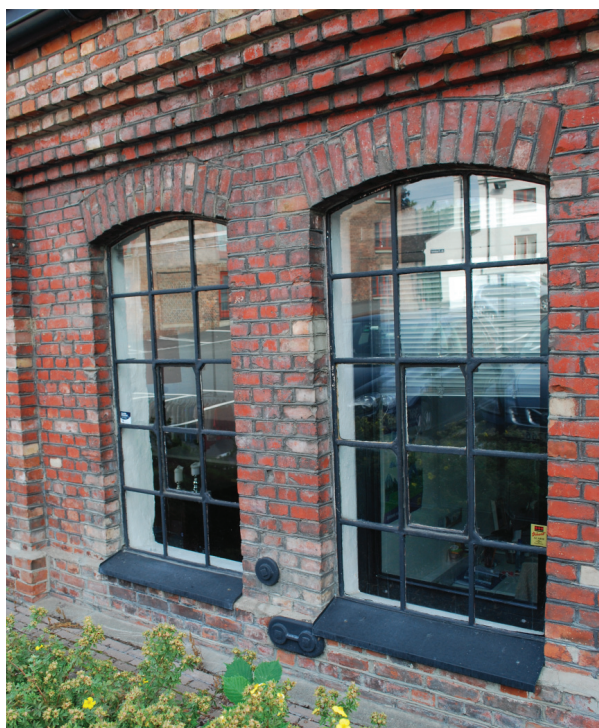
Akerselva - Vinduet til høyre har nytt vindu innenfor det gamle
