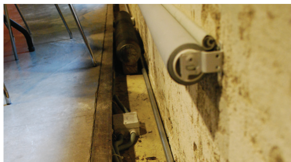
DogA - tekniske føringer mellom nyttgulvsjikt og vegg.
