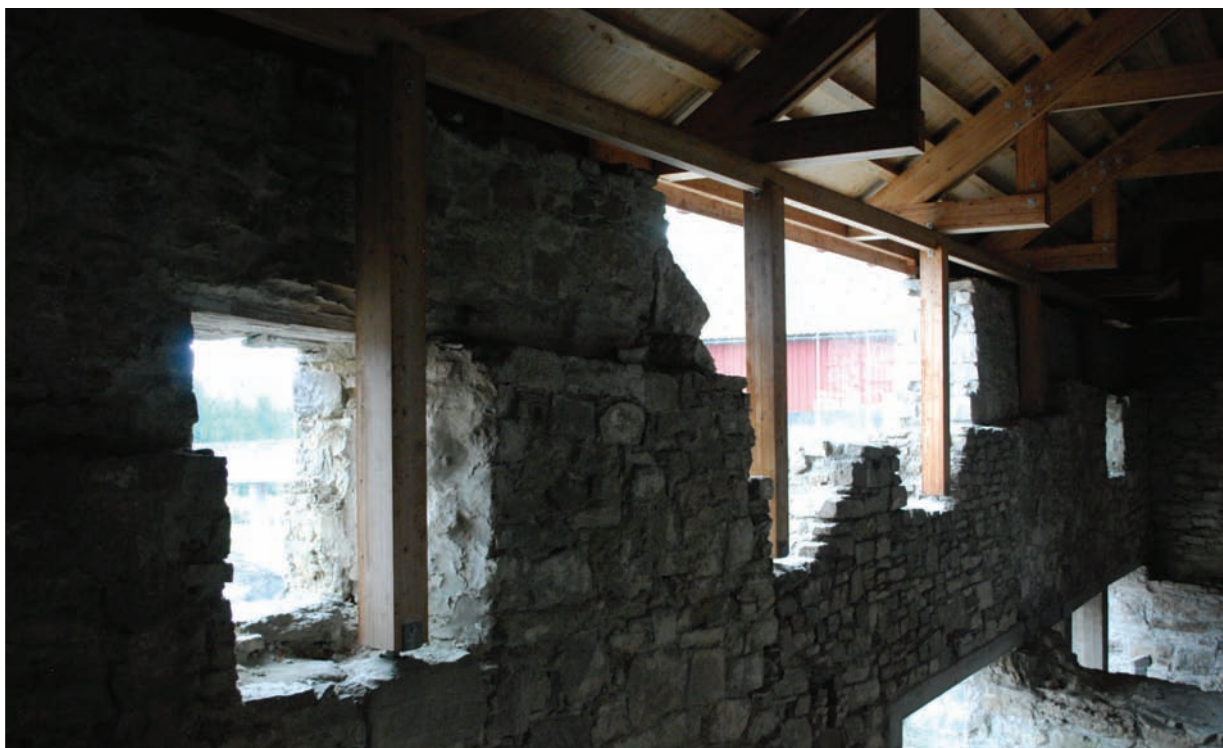
Storhamarlåvens vestfløy - søyler, uten avretting av mur
