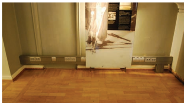
Villa Grande - føringer lagt i bokser på vegg
