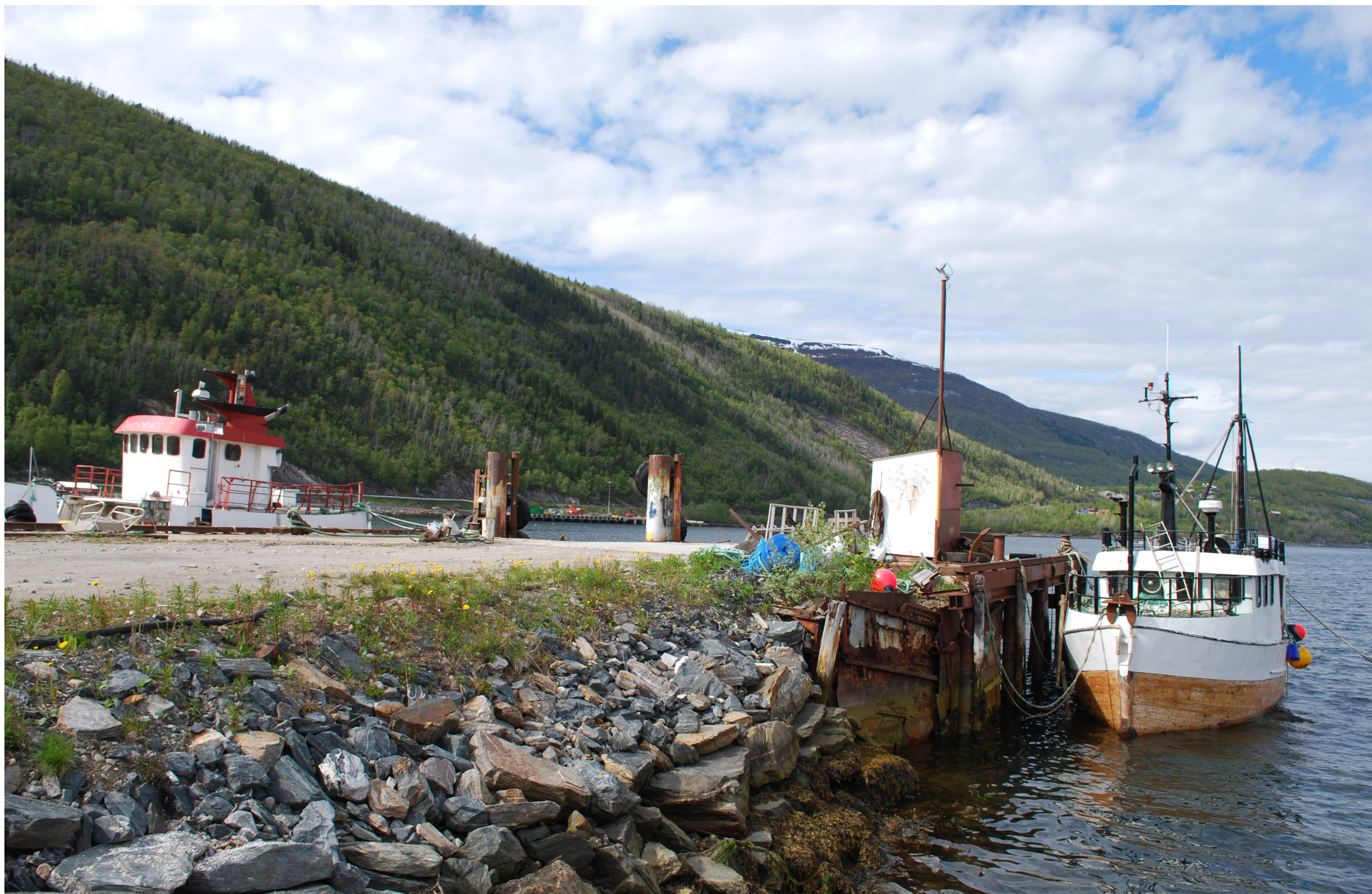
Kaiområdet. Delvis fylling, delvis jernpæler mot øst.
