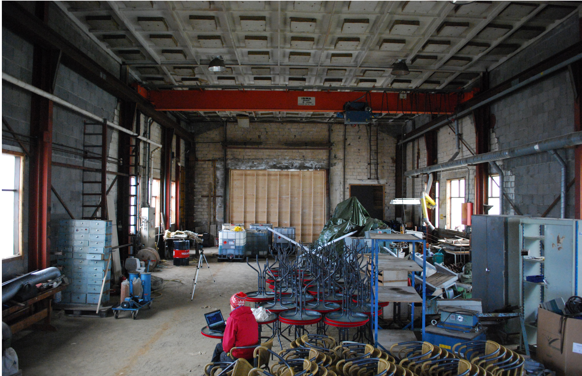
32 Interiør mot syd. Porten i sørveggen er skiftet ut med en lettvegg i tre, bindingsverk kledd på utsiden med trepanel.
