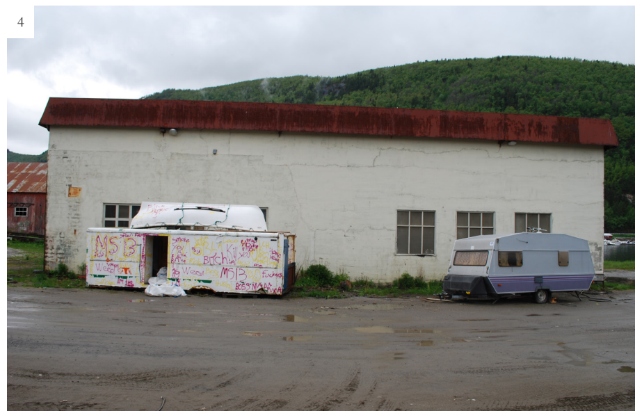
Eksteriørfoto. 1) Fasade sør, 2) Fasade vest, 3) Fasade nord, 4) Fasade øst.
