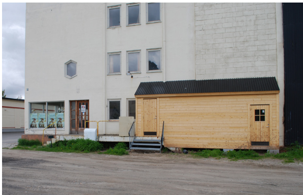
2 Inngangspartiet i øst, store vinduer i veggen. Tilbygget er for at artistene skal kunne bevege seg fra backstage til scene
