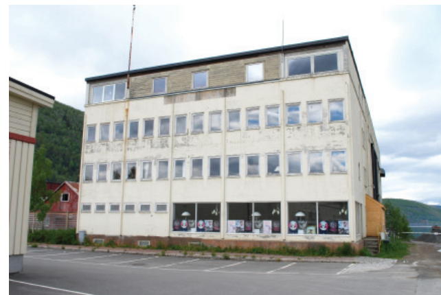
Administrasjonsbygget fra 1971 inneholdt butikk, kontor, leiligheter, garderobebelegg og kantine for arbeiderne.
