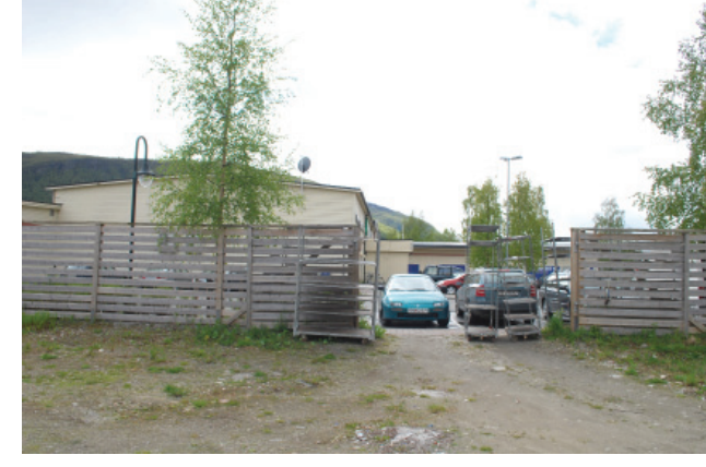
Gjerde oppført i etter at de nye parkeringsplassene ble anlagt ved butikksenteret.
