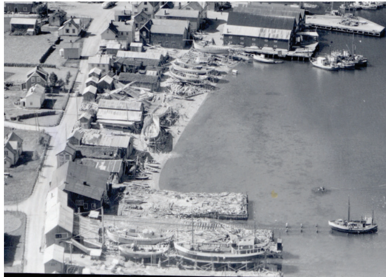
Verftet Drageslipen i forgrunnen, med to slipanlegg og mekanisk verksted. (Foto: Widerøe 1950)
