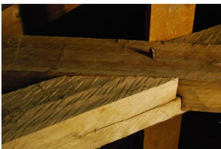
Døme på sprettelgging frå takstol i Selbu kyrkje i Trøndelag, ei steinkyrkje frå omlag 1150. Prøver av treverket viser at det er felt vinteren 1176-77 (Storsletten 2002b: 253).
