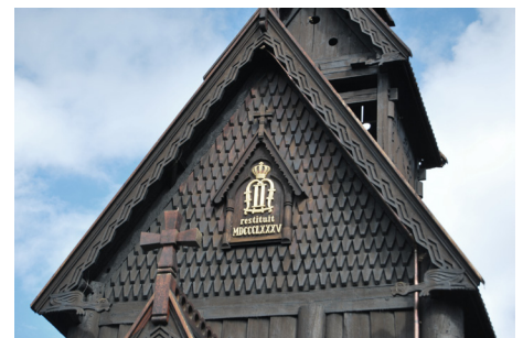
Vestgavlen med restaurert Kong Oscar II-monogram og utskifta kors, etter gjennomført vedlikehaldsarbeid.
