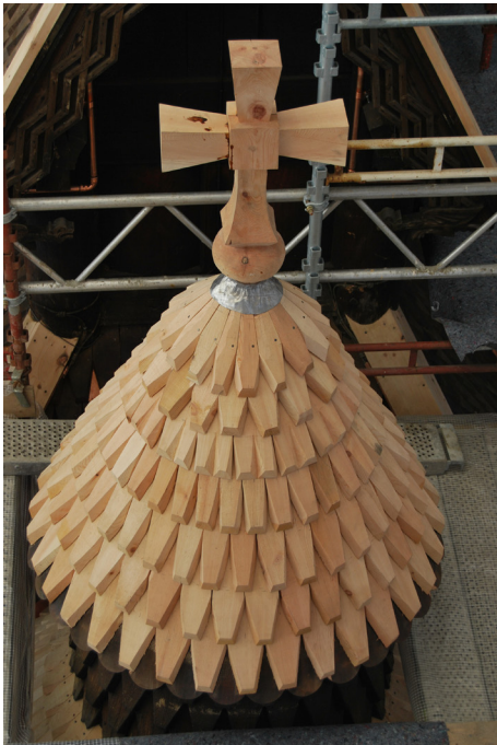
Alle takspon vart skifta ut i 2012. Her er apsishatten nytækka og med nytt kors.
