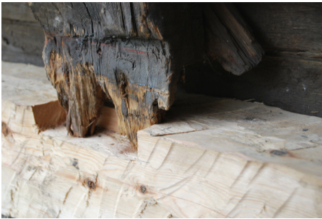
Nytt tre møtar gamalt: prosessuelt autentisk istandsetting av Undredal stavkyrkje, arbeid utført av Nedre Jølster Bilelag 2012.
