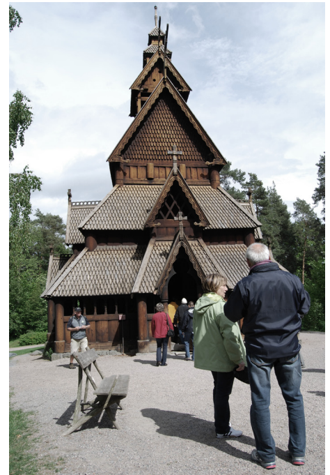
Gol stavkyrkje sommaren 2011, før vedlikehaldsarbeid i samband med stavkyrkjeprogrammet.
