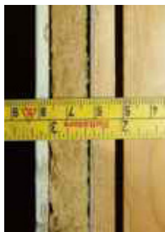
Veggtykkelse målt med tømmermåler og tommestokk
