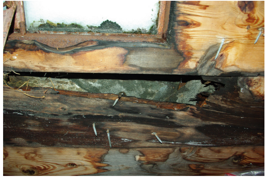
Deler av taktroet er helt råtna bort, og det er delvis sikt rett ut
