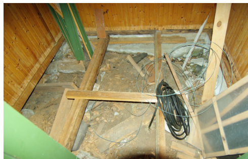
Gulv tatt opp i lagerrom ved skolestue
