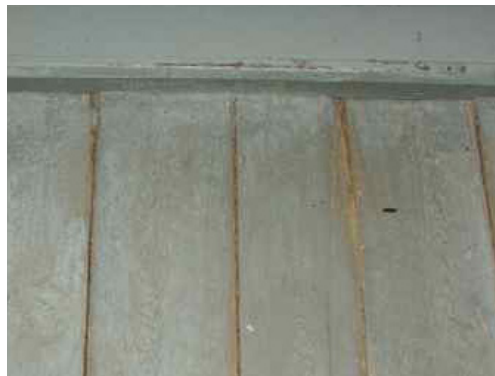
Slitte gulvbord av ujevn tykkelse, loftsgang(B2a)
