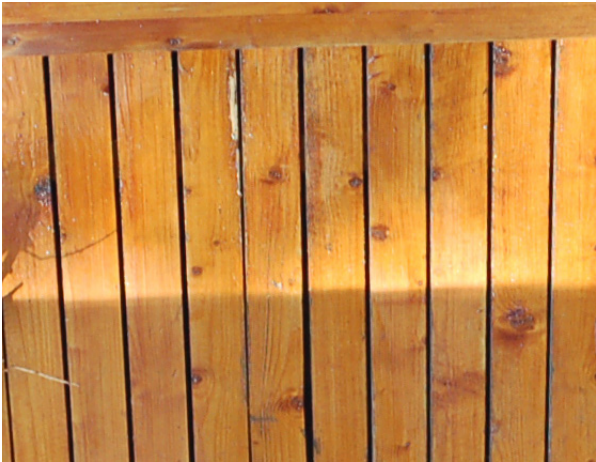
Utvendig veggkledning. 48 x 48 mm spiler malt med en blanding av tjære og linolje.
