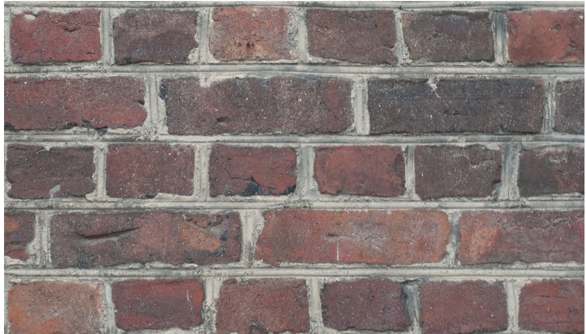
Håndslått, hardbrent tegl. 54 x 108 x 228 mm. Veggmateriale i brukerhus, utvendig og innvendig.
