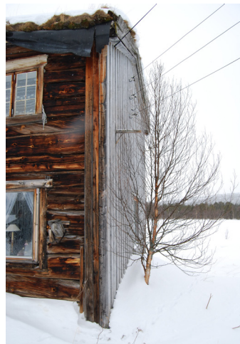
Panelkledd i de værdharde retningene. Treet vokser i ly fra vinden
