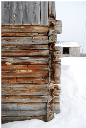
Tømmer med store dimensjoner og ovalt tverrsnitt
