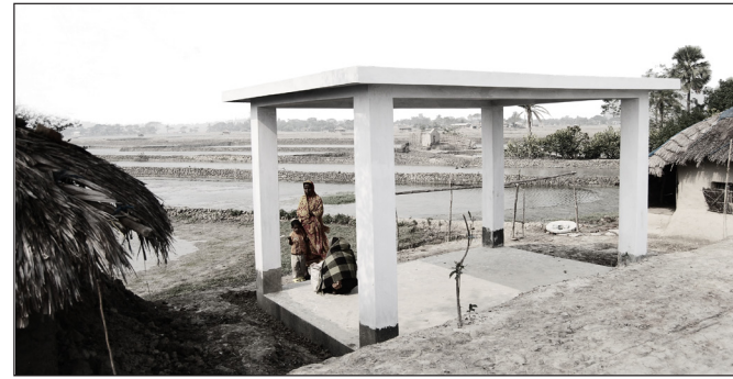
Statlig + selvgrodd. Vi så flere eksempler på hvordan staten har gått inn i små landsbyer og bygd betongstrukturer der mennesker kan søke tilflukt (syklonsentre) og fundament de rammes av sykloner og flom syklonsentre og strukturer som skal tåle flom og sykloner. stabile/ plattformer i betong de mennesker kan bygge husene sine oppå.
