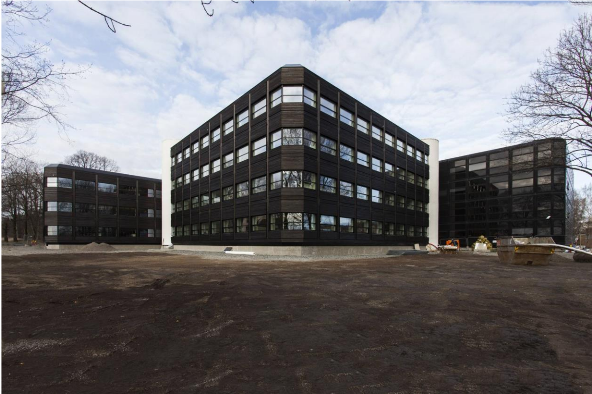
Figure 4: Powerhouse Kjørbo. (Snøhetta, 2014)
