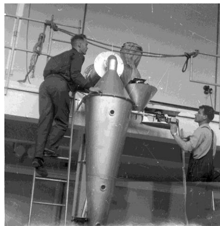
Fig. 3.1.a)–b). Tidlig på 1960-tallet bygde Institutt for kjemiteknikk ved NTH en prototyp av en type svevskikttørke tilpasset den norske tangmelindustrien etter design av NTH-professor Aksel Lydersen. Formålet var å bedre tørkemulighetene for jevnere og bedre kvalitet på tangmelet. Tørka fungerte brukbart, men ble ingen kommersiell suksess. a) (t.v.) Hele tørka ferdig oppsatt i Kjemihallen ved NTH januar 1962. (Foto: Schrøderarkivet, Trøndelag Folkemuseum, FTTF.SCH.V.072368.04). b) Konstruktører ved instituttet i arbeid med oppsettet. (Foto: Sverre Myklestad, NITT.)
