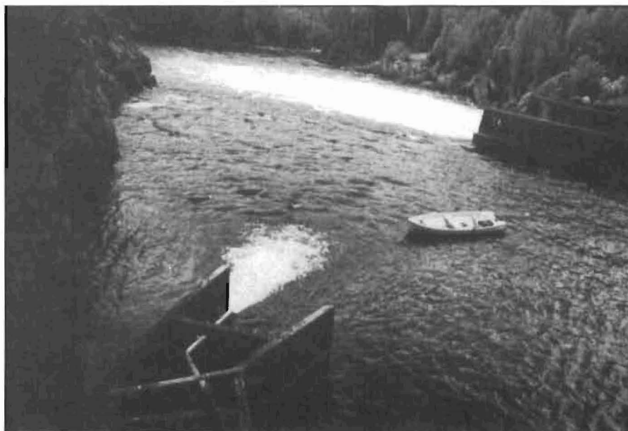
Fig. 5. Bilder av utløpet av fisketrappa i Løpet uten (øverst) og med pumpe (nederst) for tilleggsvann i drift. Det slippes overvann på bildet nederst.
