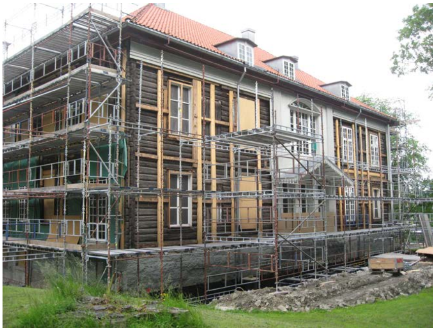
Bilde: Her er all panel demontert og sendt til reparasjon. All panel på Eidsvollsbbygningen og paviljonger har blitt demontert og reparert. Foto: Tore O. Hagelund
