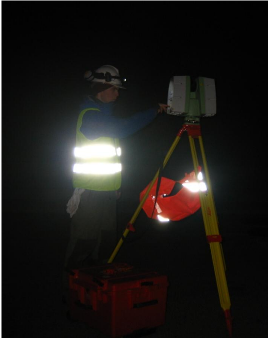
Figur 11 - Skanning av tunnel
