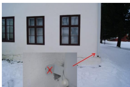
Figur 60 - naturlig target på bolt ved takrenne på hovedbygning
