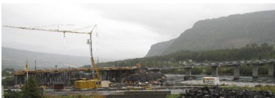
Figur 26 - Under byggeprosessen av Tingberg bru. Øyer bru ses til høyre i bildet.
