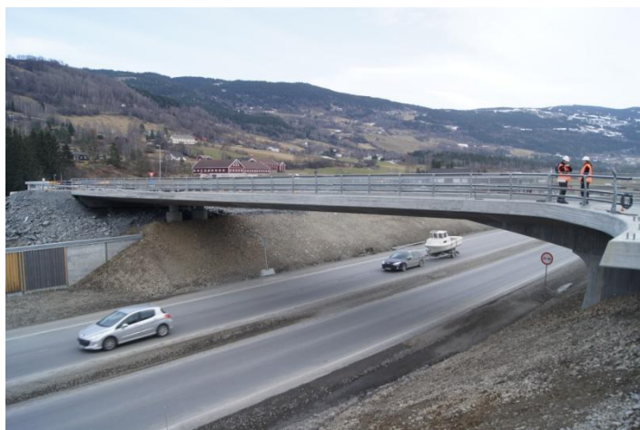
Figur 30 - Tingberg bru under skanningen.
