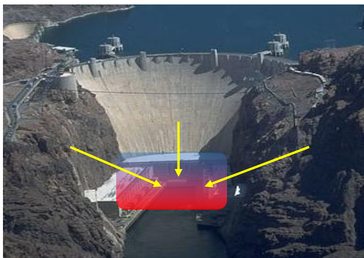
Figur 12 - Hoover demningen med piler som viser områder der det ofte oppstår deformasjoner på demninger
