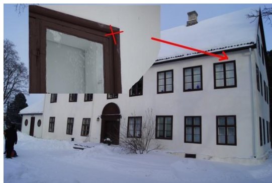
Figur 61 - naturlig target i vinduskarm på hovedbygningen
