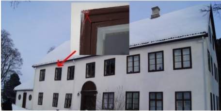
Figur 59 - naturlig target på bolt ved takrenne på hovedbygning
