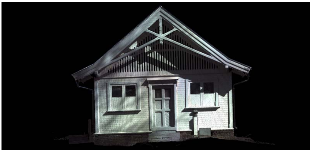
Bilde43) viser en fasade av bygning med gjennomsnitts tetthet på 1cm.
