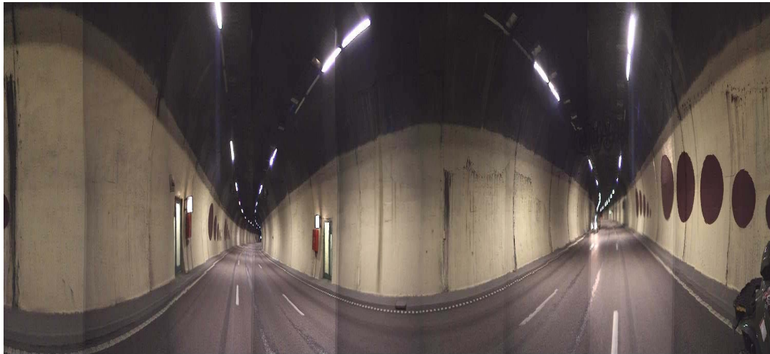
Bilde 17) Detaljert bilde av tunnel seksjon, tatt med laserskanner GS200 (mai 2004, Geoplan øst). Brukes til å finne ut hva stor deformasjon er i forhold til den teoretiske som var når tunnelen ble bygd.
