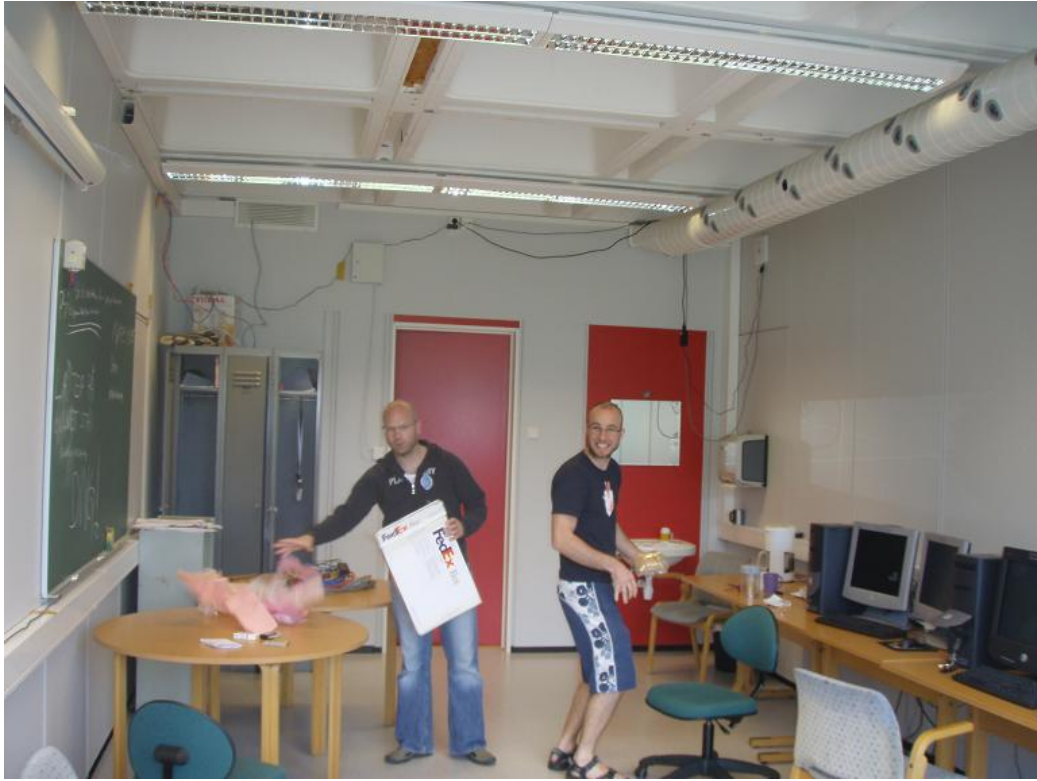
Systemet under demontering på B215.
