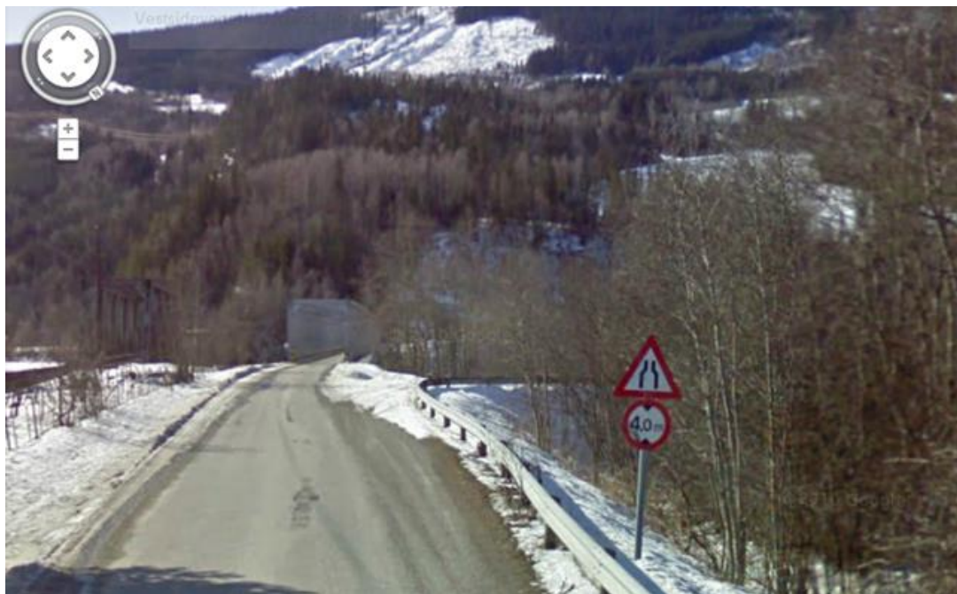
Figur 56: Smal og lav fagverksbru i stål vest for Åmillom (Fra Google streetview)
