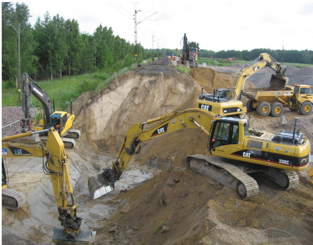
Figur 52: Utgravingen for kulvert. Referanseprosjekt fra Sverige, Statens vegvesen, foto Morten Wangen
