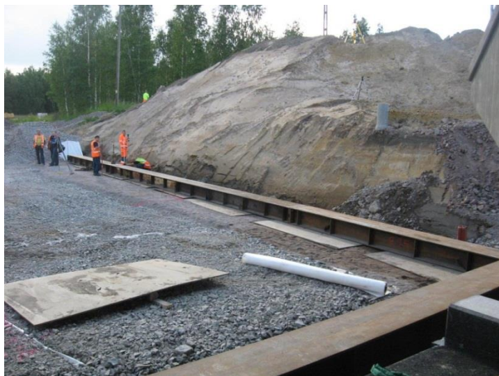
Figur 19: Skinner (sliskebane) brukt i Sverige, kilde: Statens vegvesen, foto Morten Wangen
