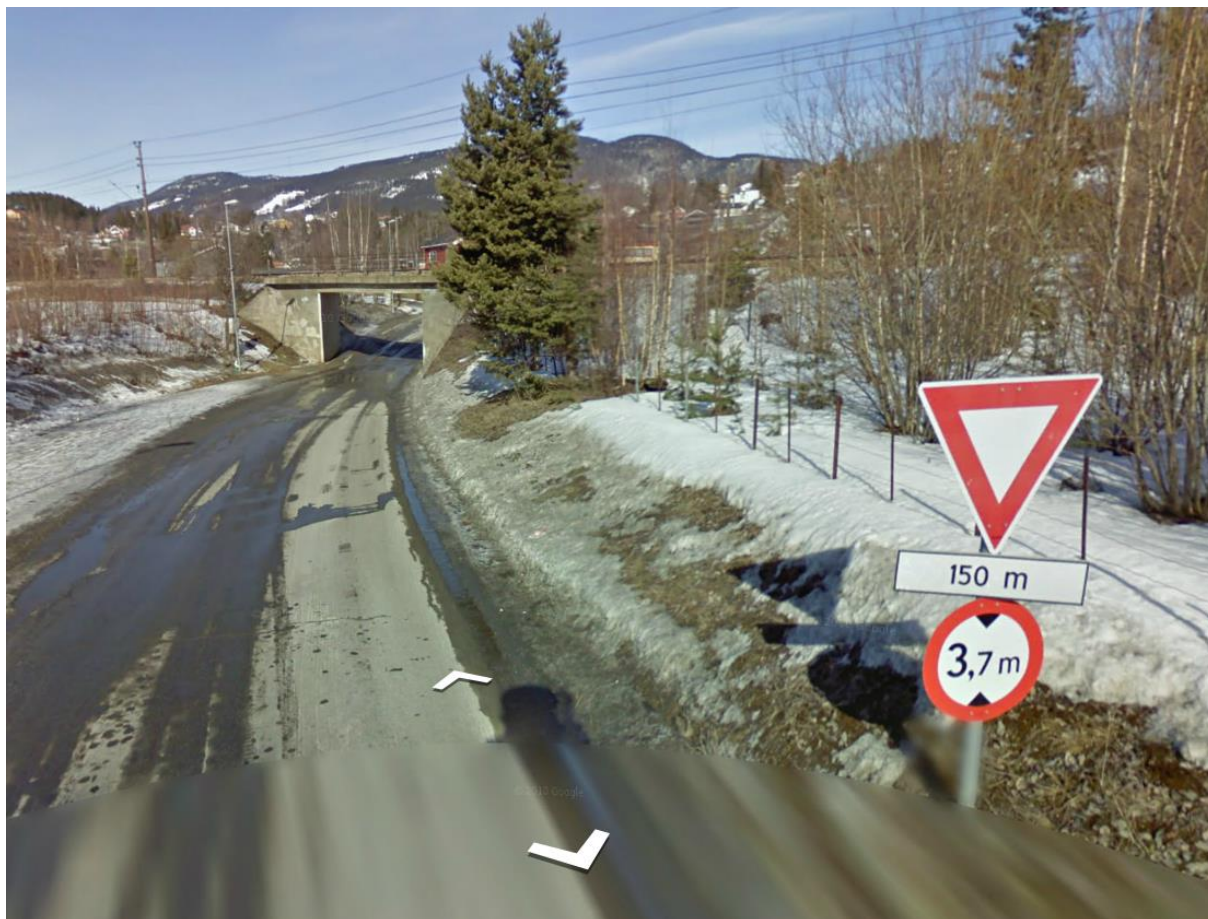
Figur 55: Smal og lav undergang under jernbanen øst for Åmillom (Fra Google streetview)
