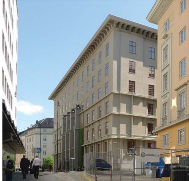
Bergen tinghus med hovedinngang mot tårnplass
