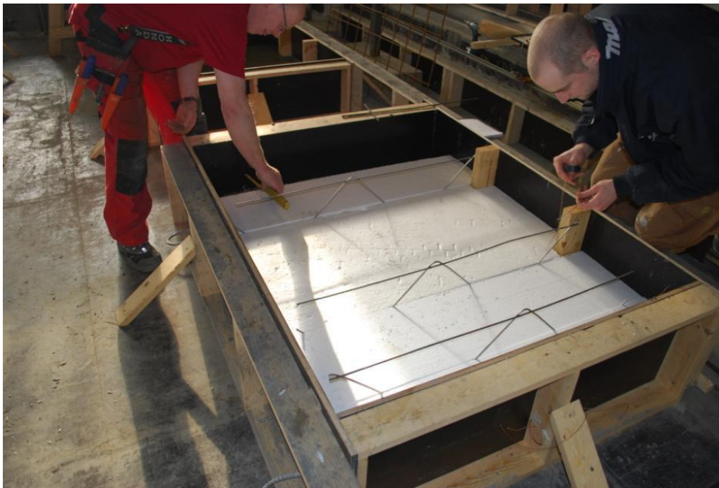
Viser diagonal armering brukt i element, Illustrasjon Bjerke
