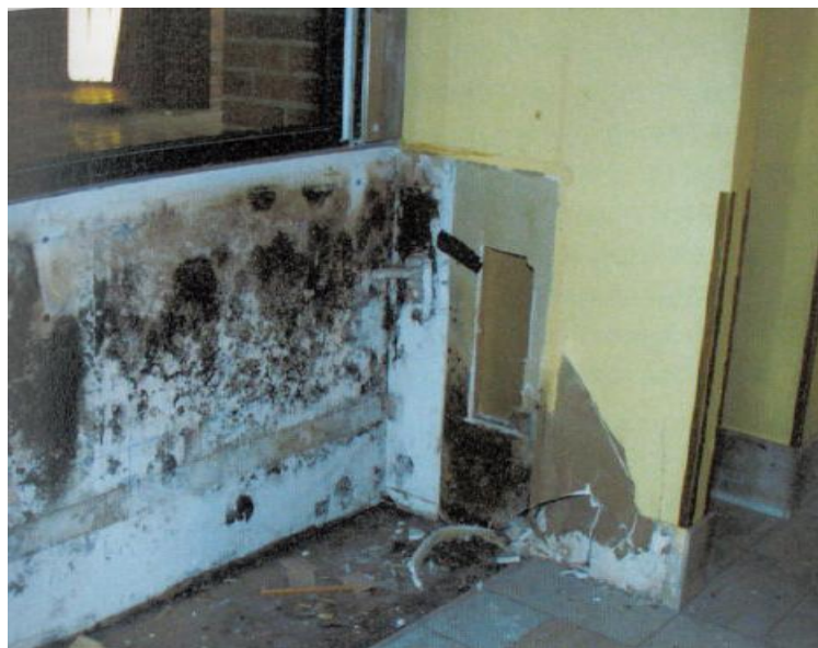
Bilde 7: Stachybotrys chartarum på gipsplater
