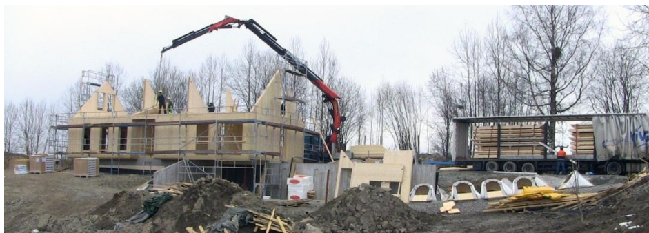
Byggeplassen. Dette er fra dag 4 i monteringsfasen. Montering av veggelementer via lastebilkrane.
