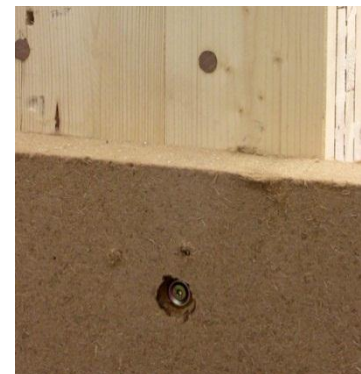
Homatherm skrudd på utsiden av Holz100 elementet
