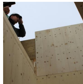
Etasjeskiller og limtrebjelke i 2. etg.
