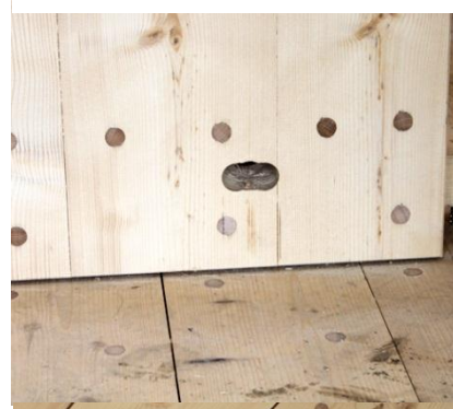
Uttak for stikkontakter i innervegg
