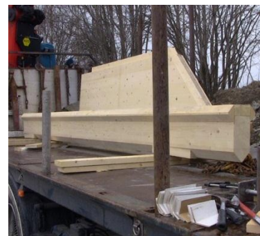
Takås klar til montering
