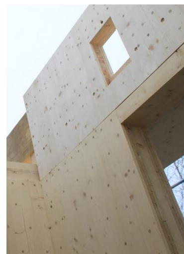
Bildet viser et Holz 100 veggelement som tilfredsstillers dagens brannkrav
