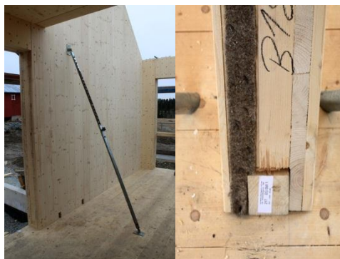
T.v. Midlertidig støtte av elementene
