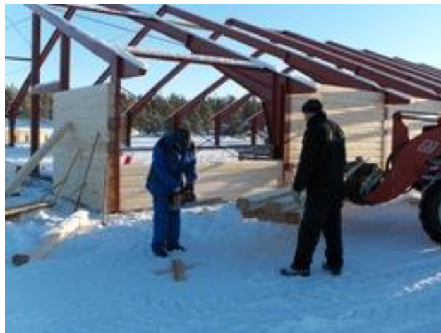
Figur 14 Her sees hvordan laftestokkene er lagt ned i spor i stålbuene
