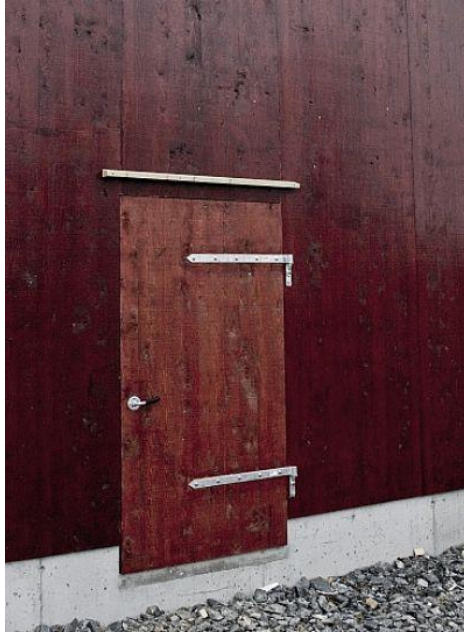
Figur 13 Med motorsag kan døråpninger lett lages
