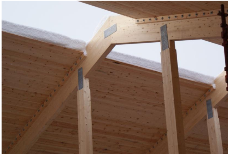
Figur 18 6" takelementer nedfelt mellom sperrer
