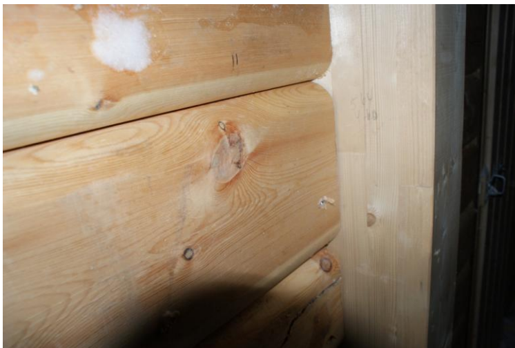
Figur 17 Vegg fra utside
