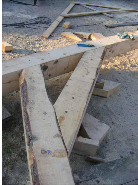
Figur 9 Detalj avstiving mellom tak-vegg Foto: Landbygg AS
