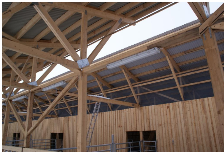
Figur 23 Vindbremseduk over veggkledning
