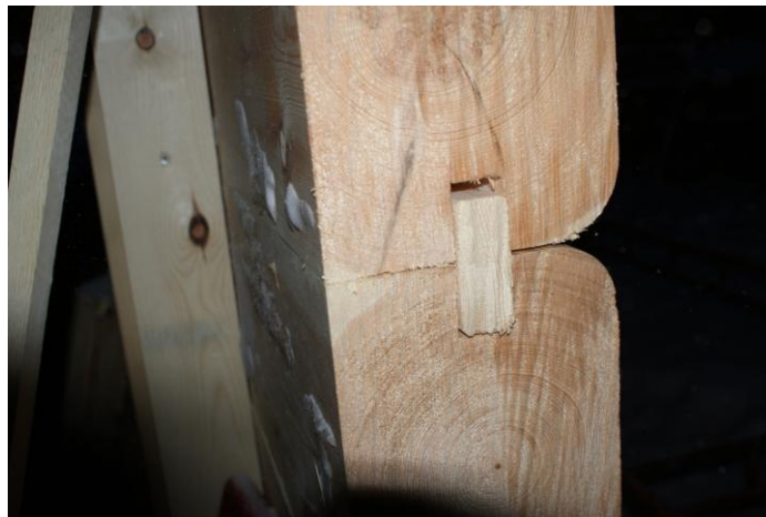
Figur 19 Løs fjær i innfreste spor
