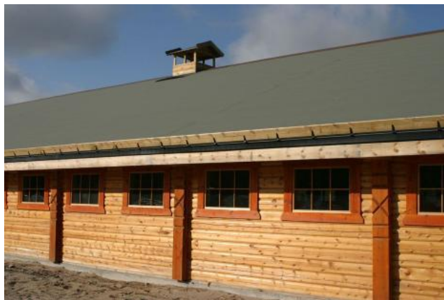
Figur 15 Det ferdige resultat før torv er lagt
