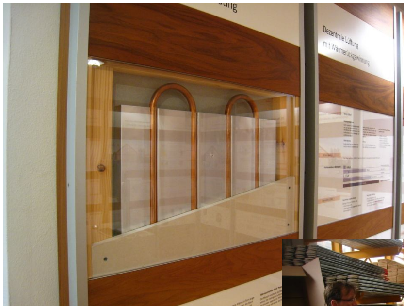
Vindu som viser hvordan varmerørene er lagt i vegg
